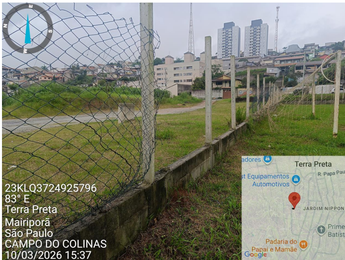
Foto 4 – ÁREA DOS ALAMBRADOS
