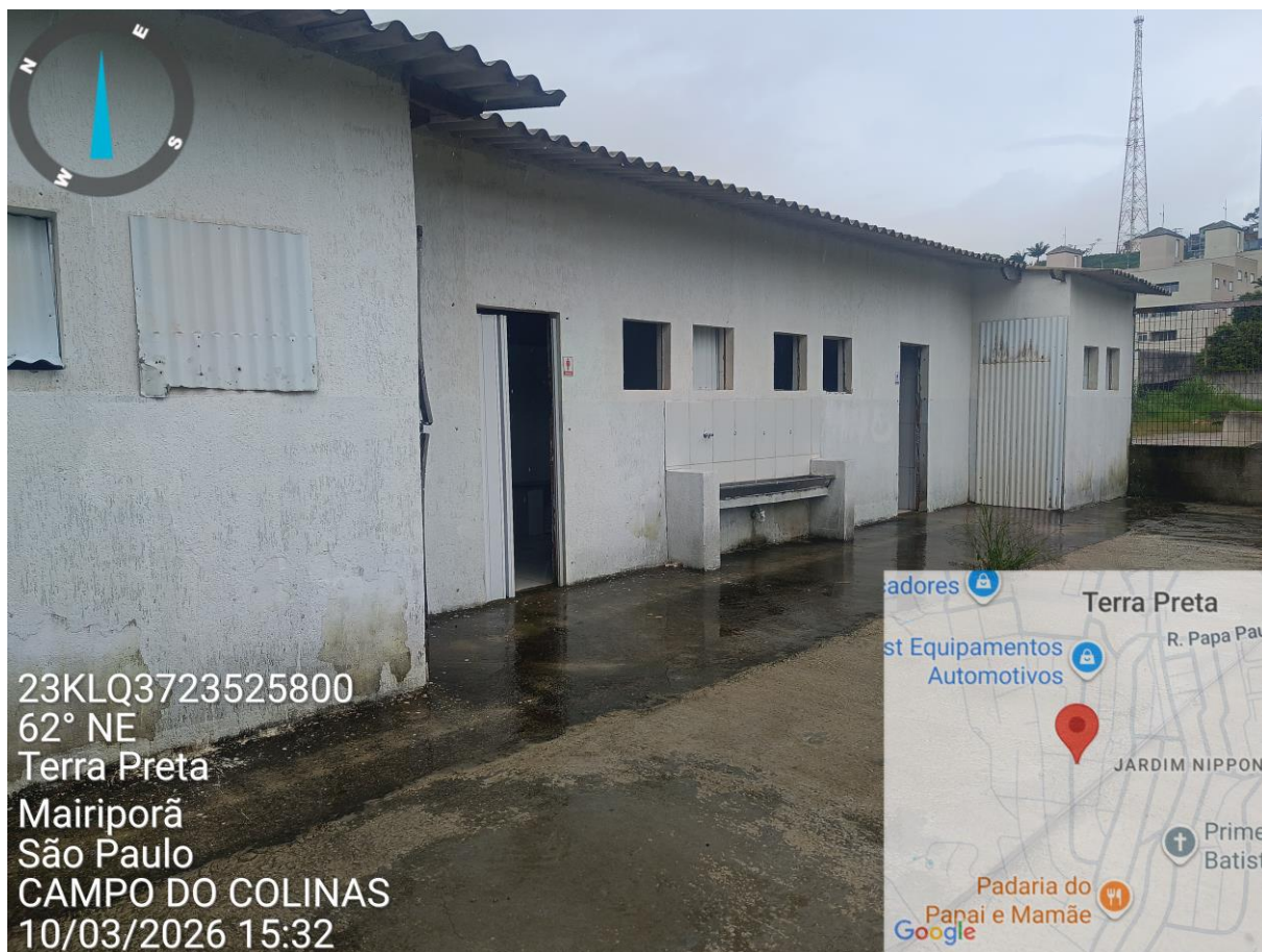
Foto 3 – ÁREA DOS VESTIÁRIOS
