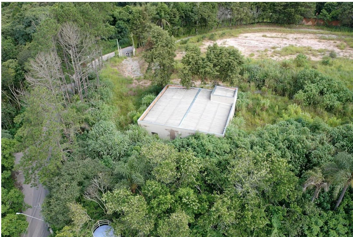
Figura 3 - Imagem área do lote e edificação existente. Acervo Próprio, 2026.
