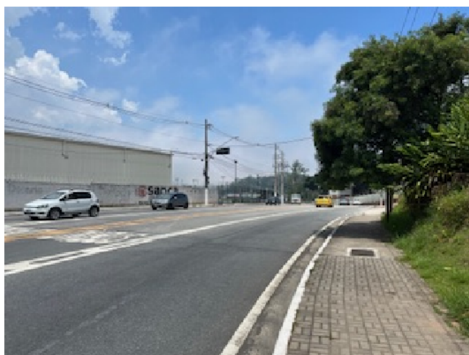
Trecho da Estrada Galvão Bueno onde está localizada a área "001" avalianda.
