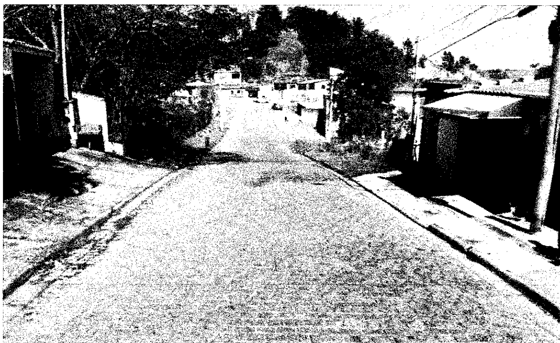
Figura 2: Trecho da Rua Alemanha no qual será objeto de pavimentação asfáltica.
