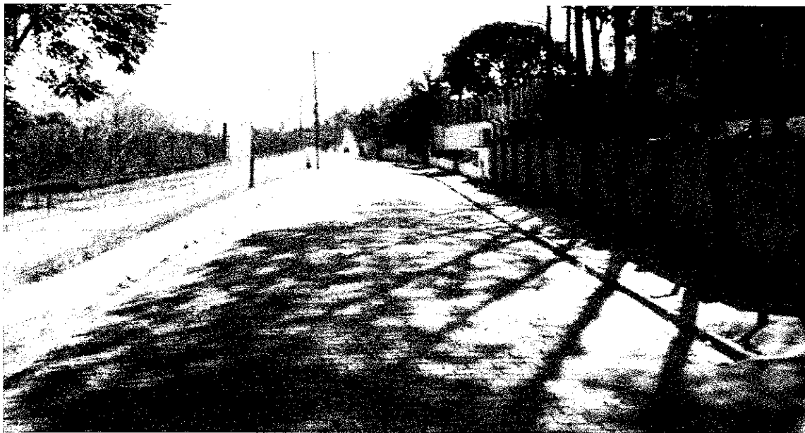
Figura 1: Trecho da Avenida América no qual será objeto de pavimentação asfáltica.
