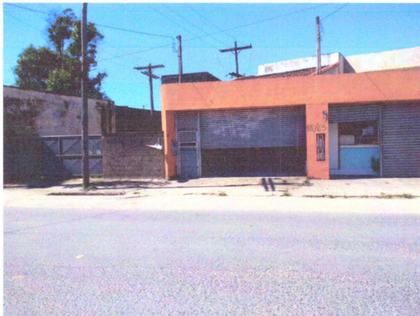
Foto nº. 1 - Avaliador posicionado na frente do imóvel.
