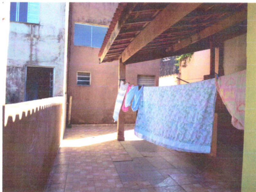
Foto nº. 12 - Avaliador posicionado na edícula olhando para o salão.
