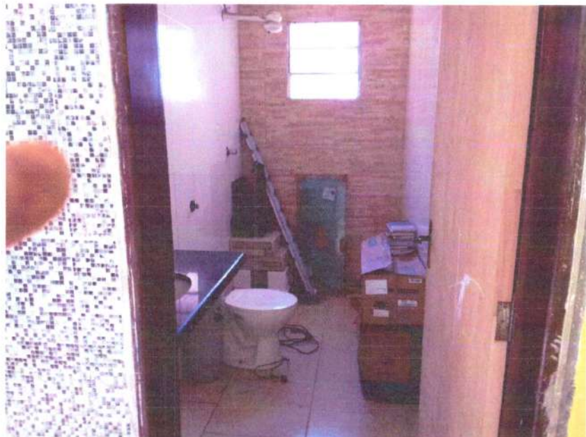
Foto nº. 4 - Avaliador posicionado na frete do banheiro do salão.
