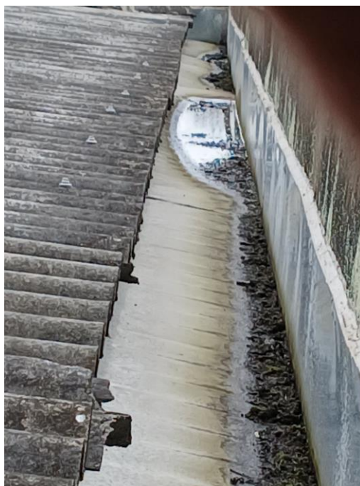
Figura 1 – Vista geral da cobertura e da calha longitudinal.
