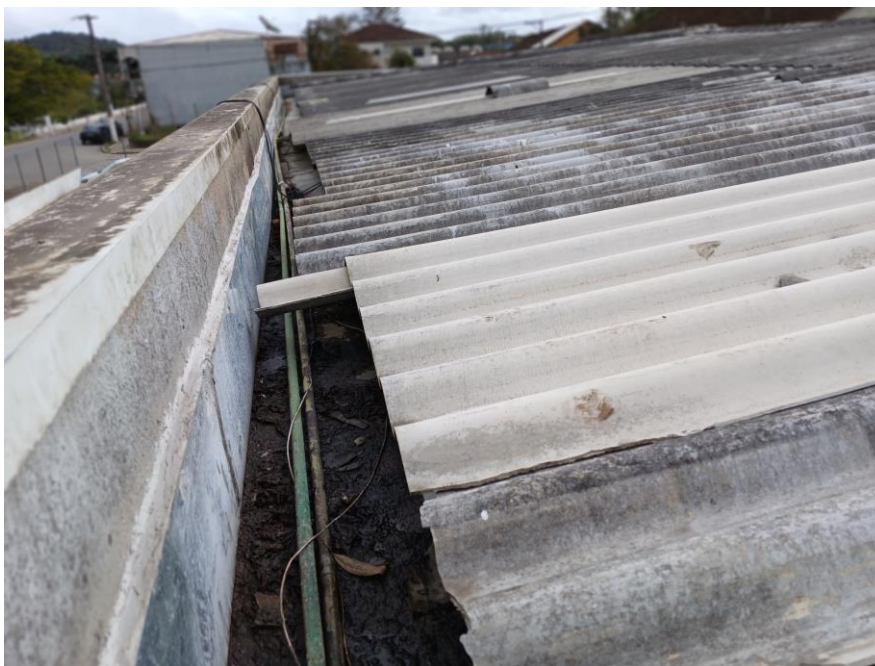
Figura 3 – Acúmulo de resíduos e água parada na calha.
