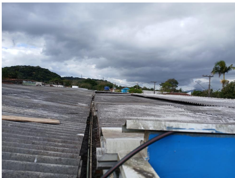
Figura 9 – Sedimentos acumulados junto ao ralo.
