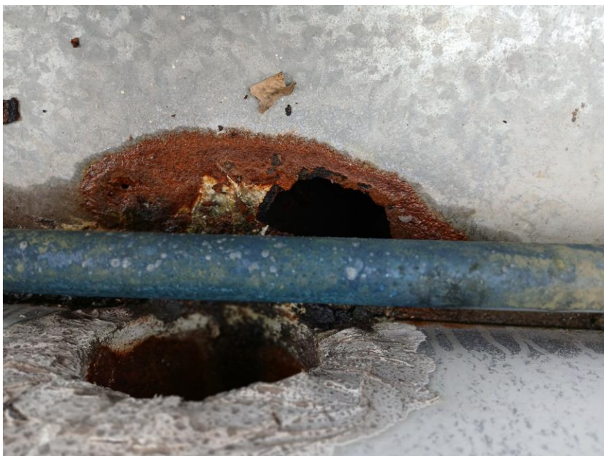
Figura 3 – Acúmulo de resíduos e água parada na calha.
