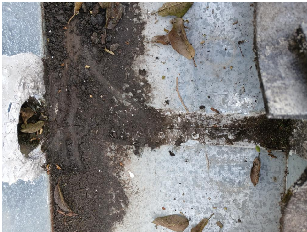
Figura 9 – Sedimentos acumulados junto ao ralo.
