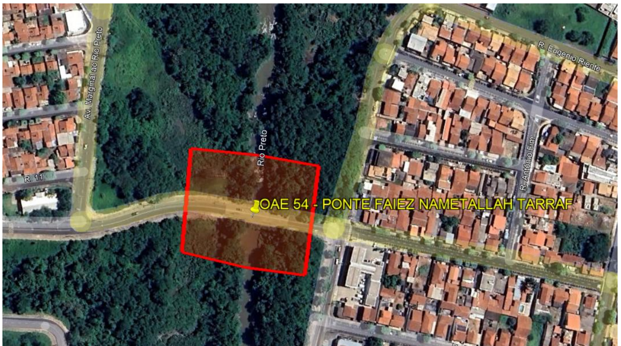
Figura 02: OAE 54 – Ponte Faiez Nametallah Tarraf.
