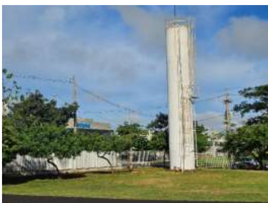
Caixa d'água, Sede Administrativa.
