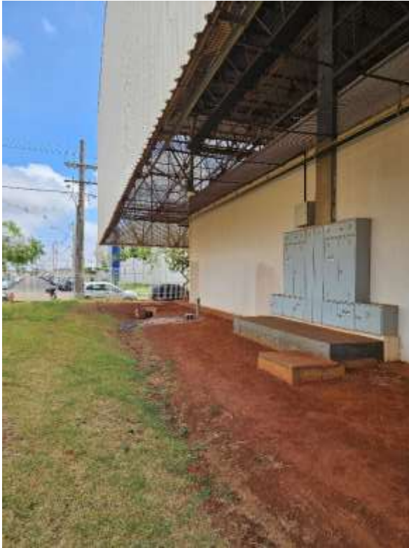
Área externa, fundo.
