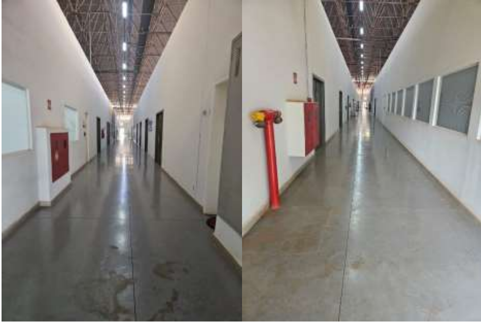
Corredor principal (à esq.) e corredor secundário (à dir.).
