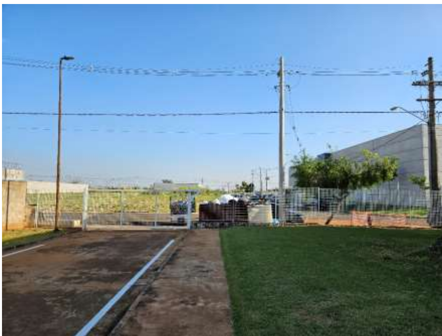
Área externa, fundo.
