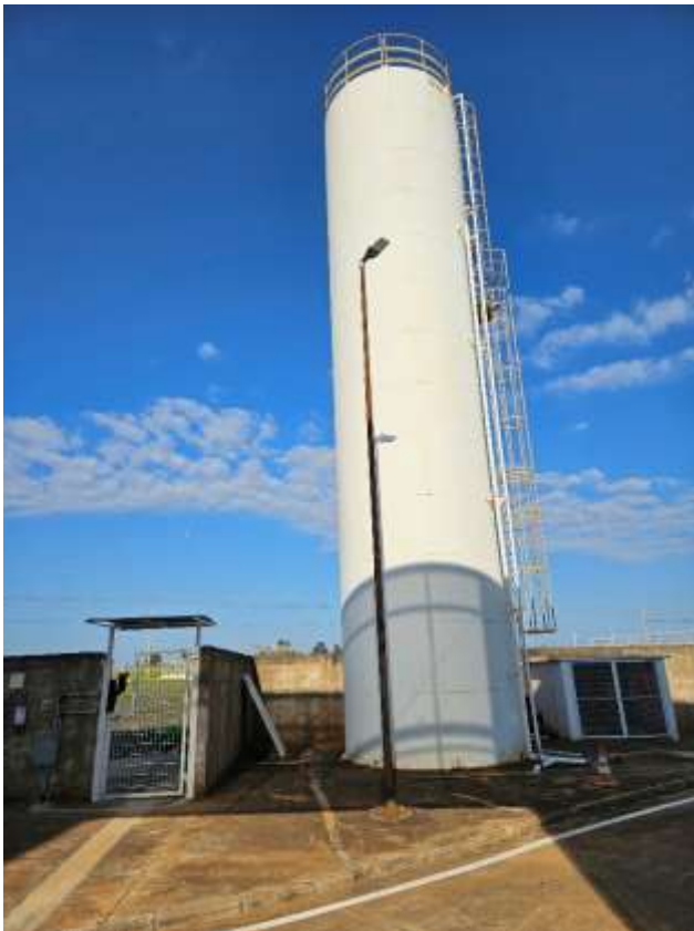
Reservatório de água metálico cilíndrico (externo) - 150m 3
