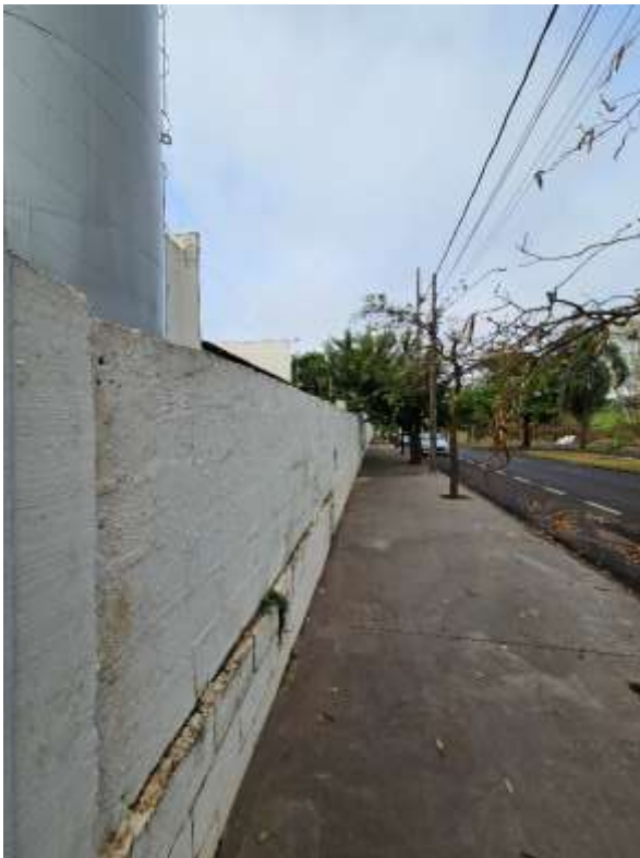
Muro frontal (vista externa).
