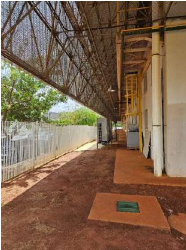
Área externa, lateral.
