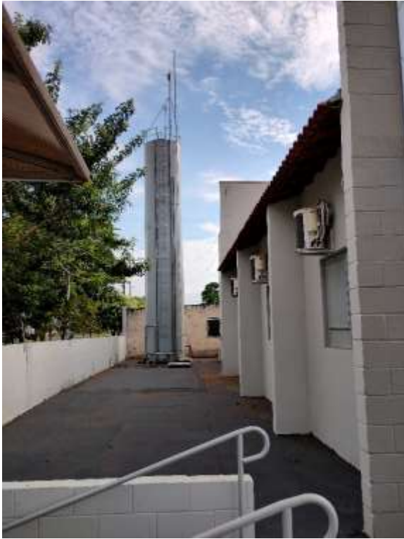
Muro frontal (vista interna).
