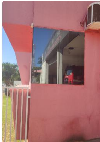
Janela lateral CAD 1,40 x 1,43 m; 02 vidros de 0,70 x 1,43 m
