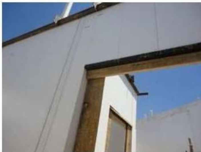
FIGURA 13 – Escoramento de aberturas de portas para concretagem
