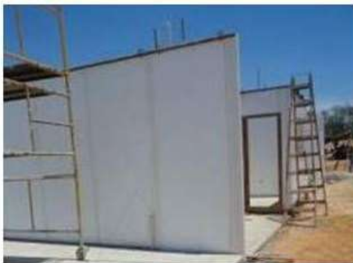
FIGURA 11 – Painéis de PVC posicionados e escorados
