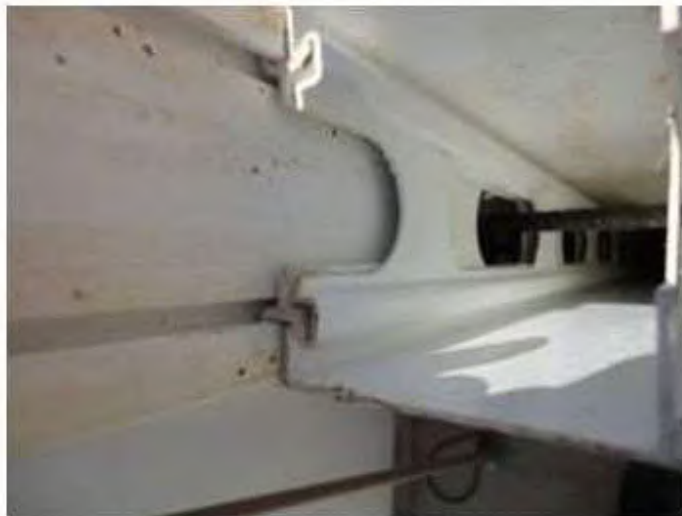
FIGURA 12 – Ferragem posicionada na região da contra-verga
