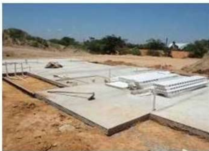
FIGURA 08 – Elemento de fundação com planicidade adequada
