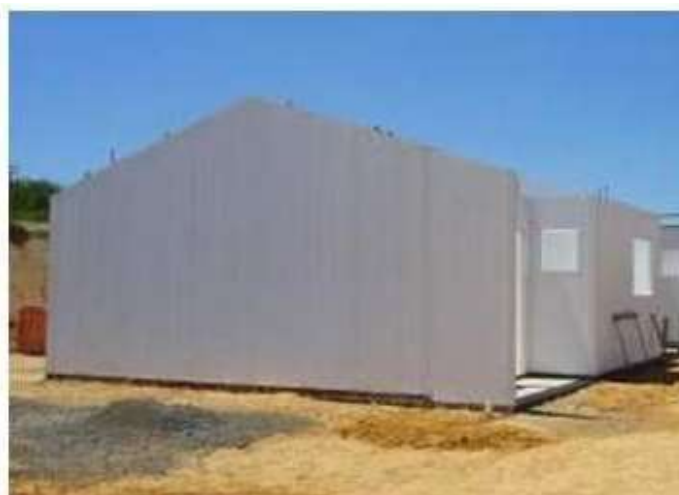
FIGURA 14 – Painéis de PVC concretados
