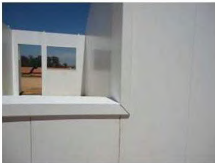
FIGURA 15 – Abertura das janelas com acabamentos em PVC
