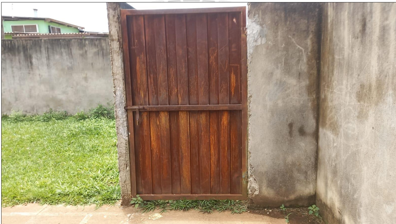
Foto 12: portão metálico aos fundos
