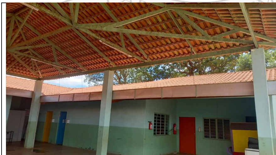
Foto 7: cobertura do pátio 2
