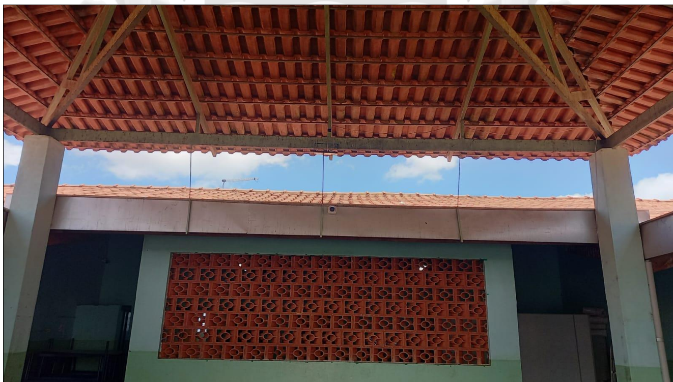
Foto 9: cobertura do pátio 2
