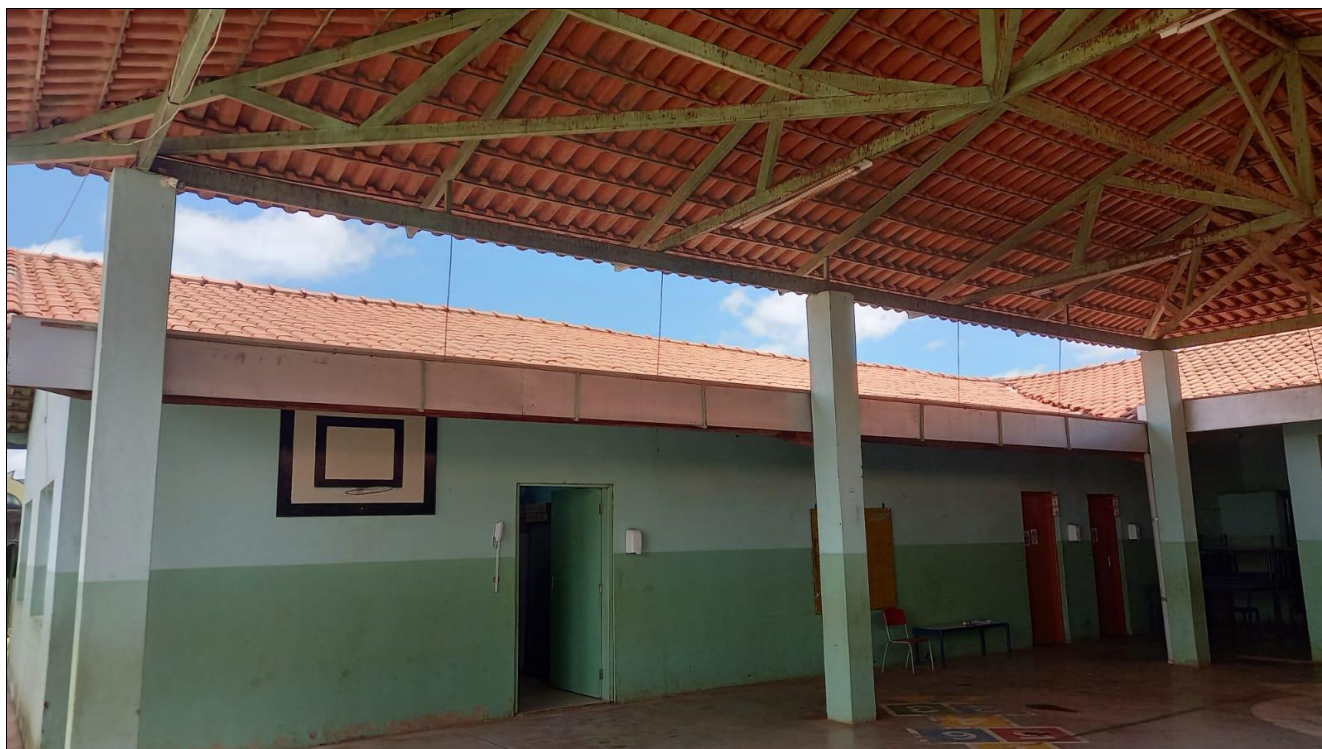
Foto 8: cobertura do pátio 2
