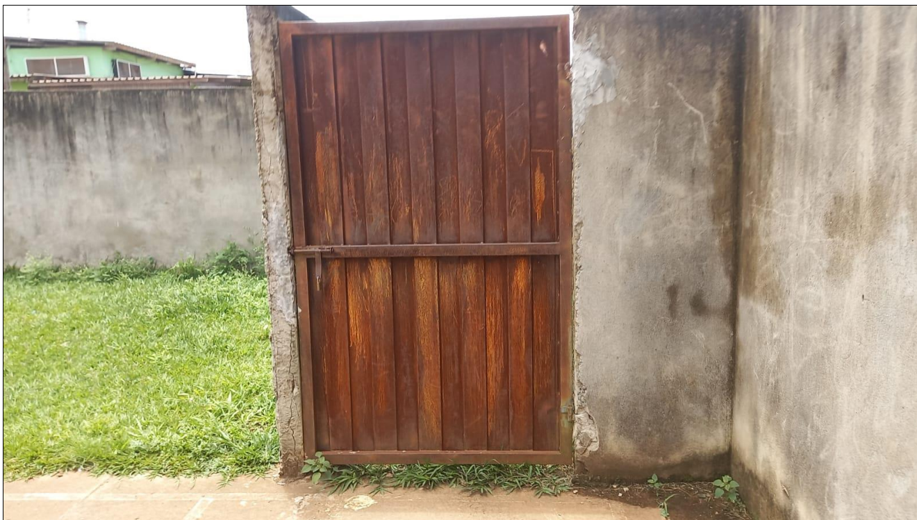
Foto 11: portão metálico a ser restaurado
