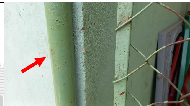
Foto 13: local a ser instalado o fecho metálico
