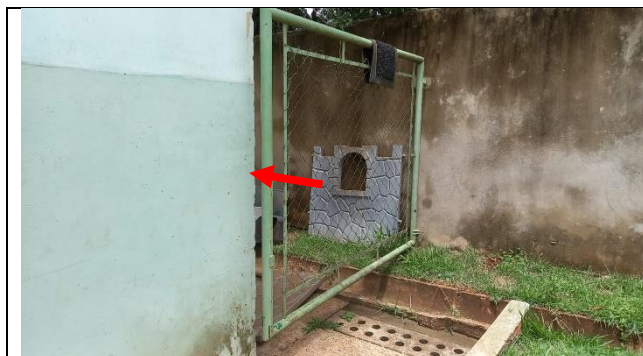
Foto 12: local a ser instalado o fecho metálico
