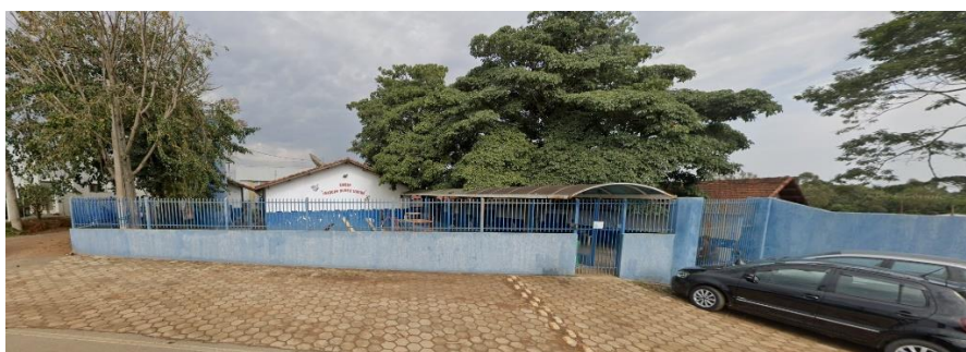
Foto 02- muro a demolir entrada
