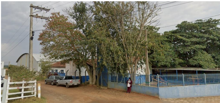
Foto 05- lateral, implantar nova entrada.
