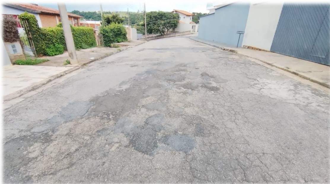
Imagem 08 – Sentido Rua das Jacarandás
