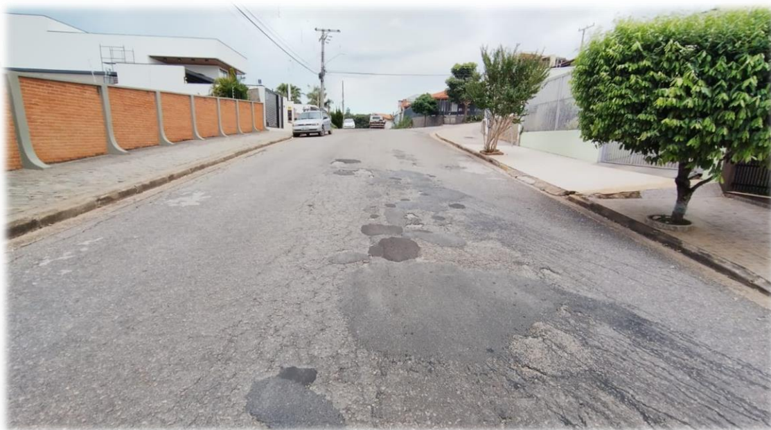
Imagem 04 – Sentido Rua das Jacarandás
