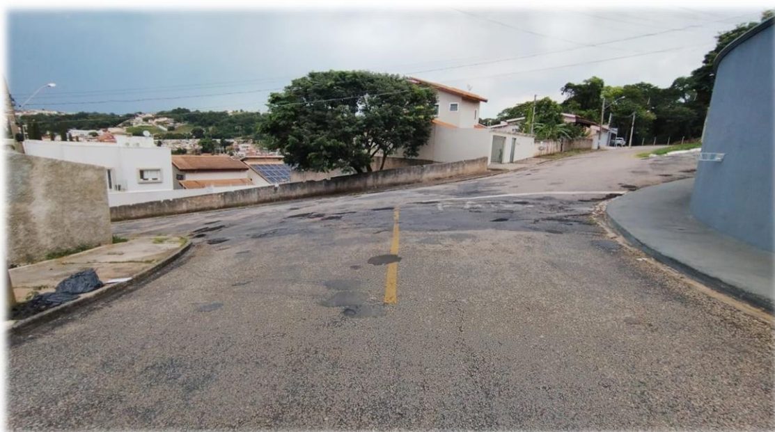
Imagem 10 – Sentido Rua das Jacarandás
