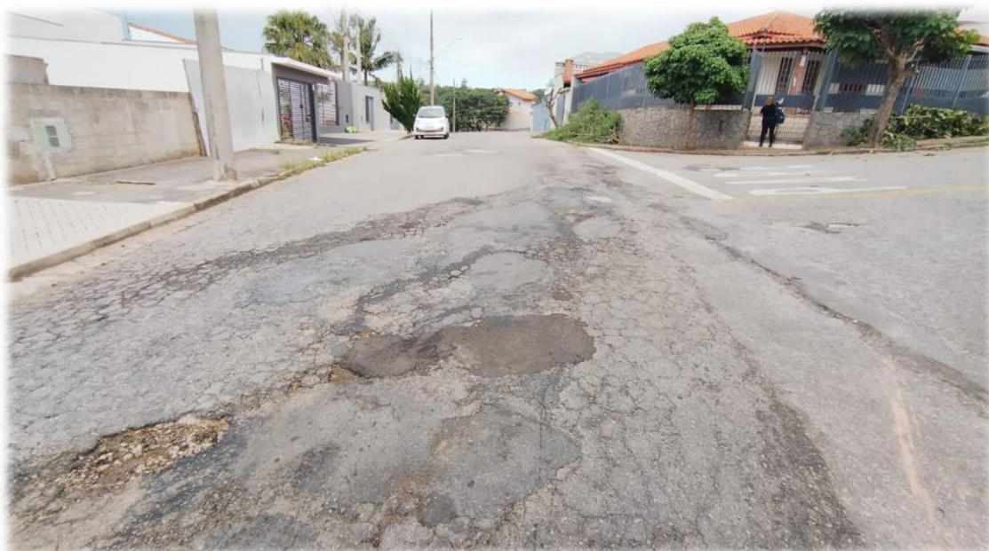
Imagem 06 – Sentido Rua das Jacarandás
