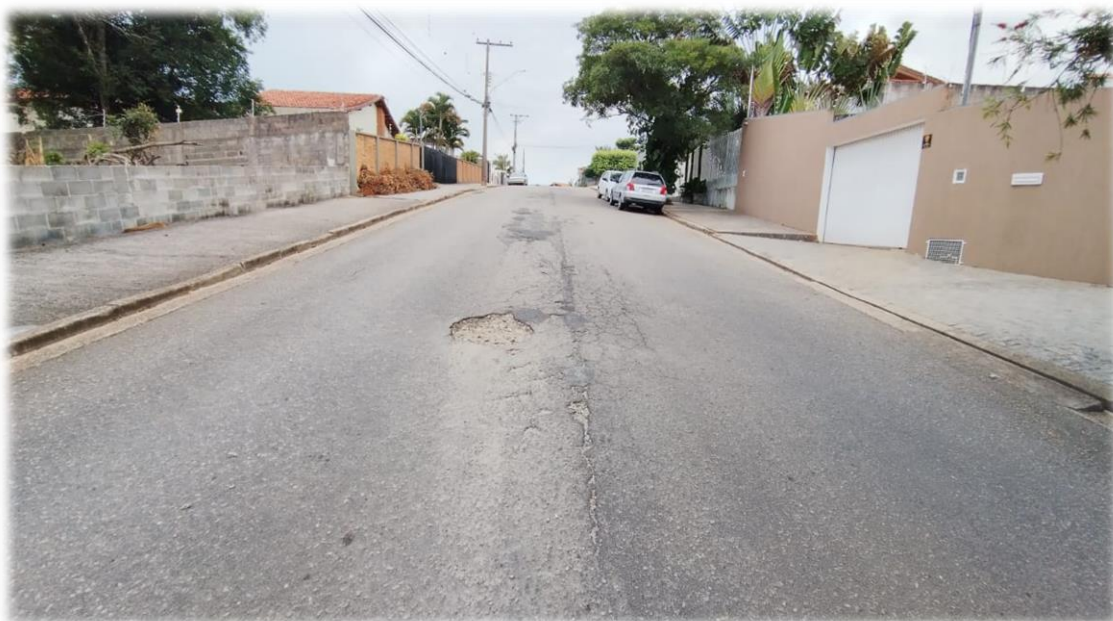
Imagem 02 – Sentido Rua das Jacarandás
