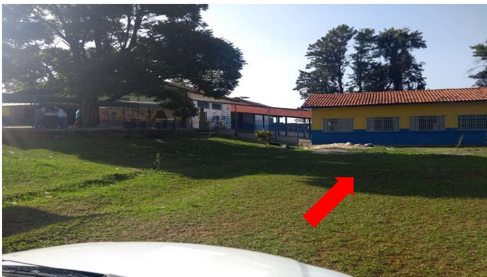
Foto 01 – Local da ampliação.
