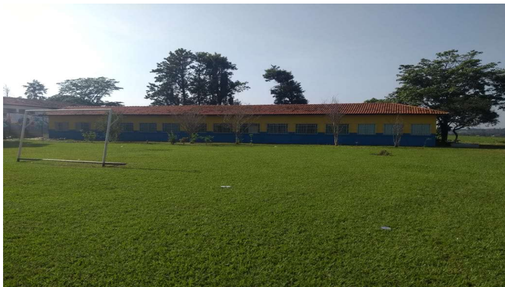
Foto 06 – Vista frontal do local da ampliação.
