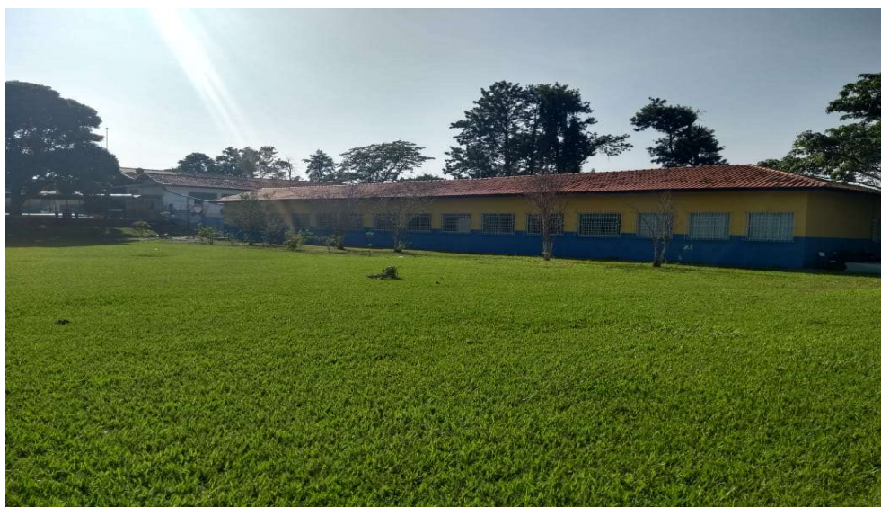
Foto 02 – Vista frontal do local da ampliação.
