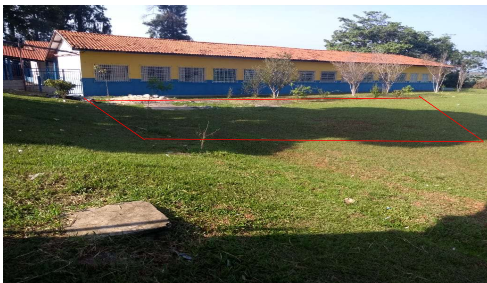
Foto 04 – Vista frontal do local da ampliação.
