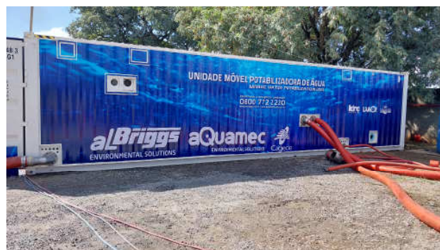
Unidade de Tratamento por Membranas de UF (Foto ilustrativa) – 180 m³/hora.
