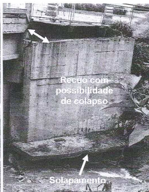
Interdição parcial da via
