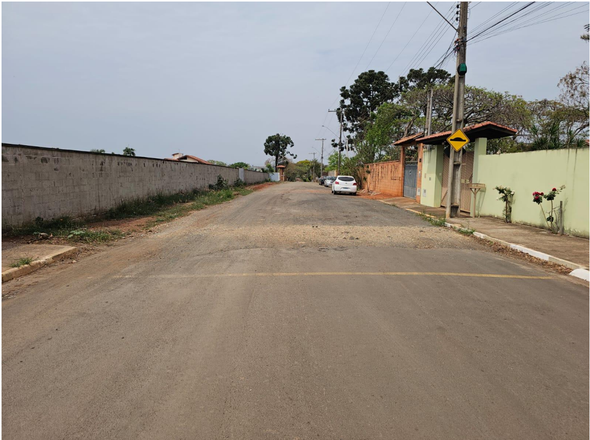
Foto 01: Início do trecho a ser pavimentado da Rua Lázaro Ribeiro da Silva.
