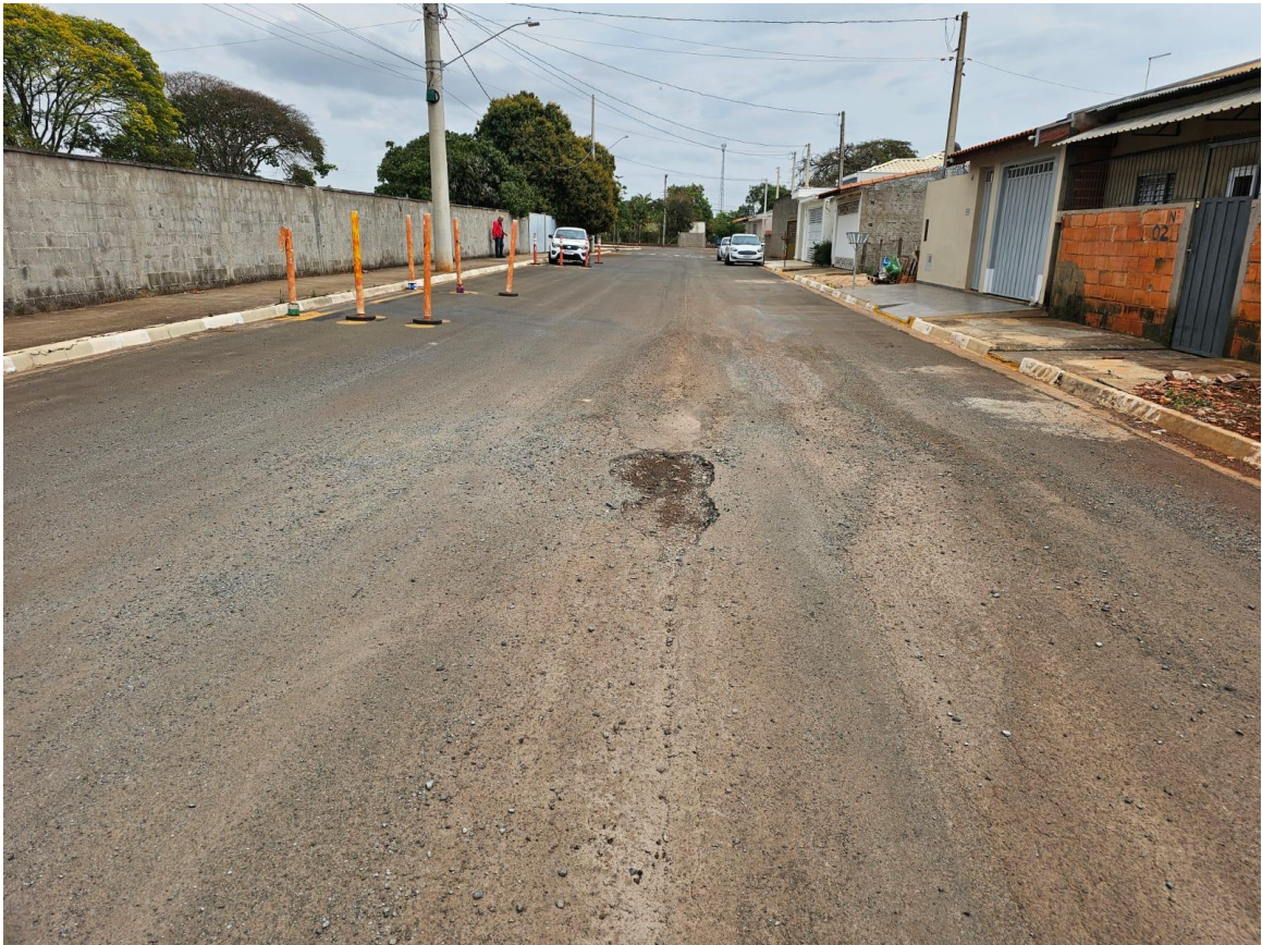
Foto 11: Trecho que receberá recapeamento asfáltico da Rua Maria Ap. Camargo Barros.
