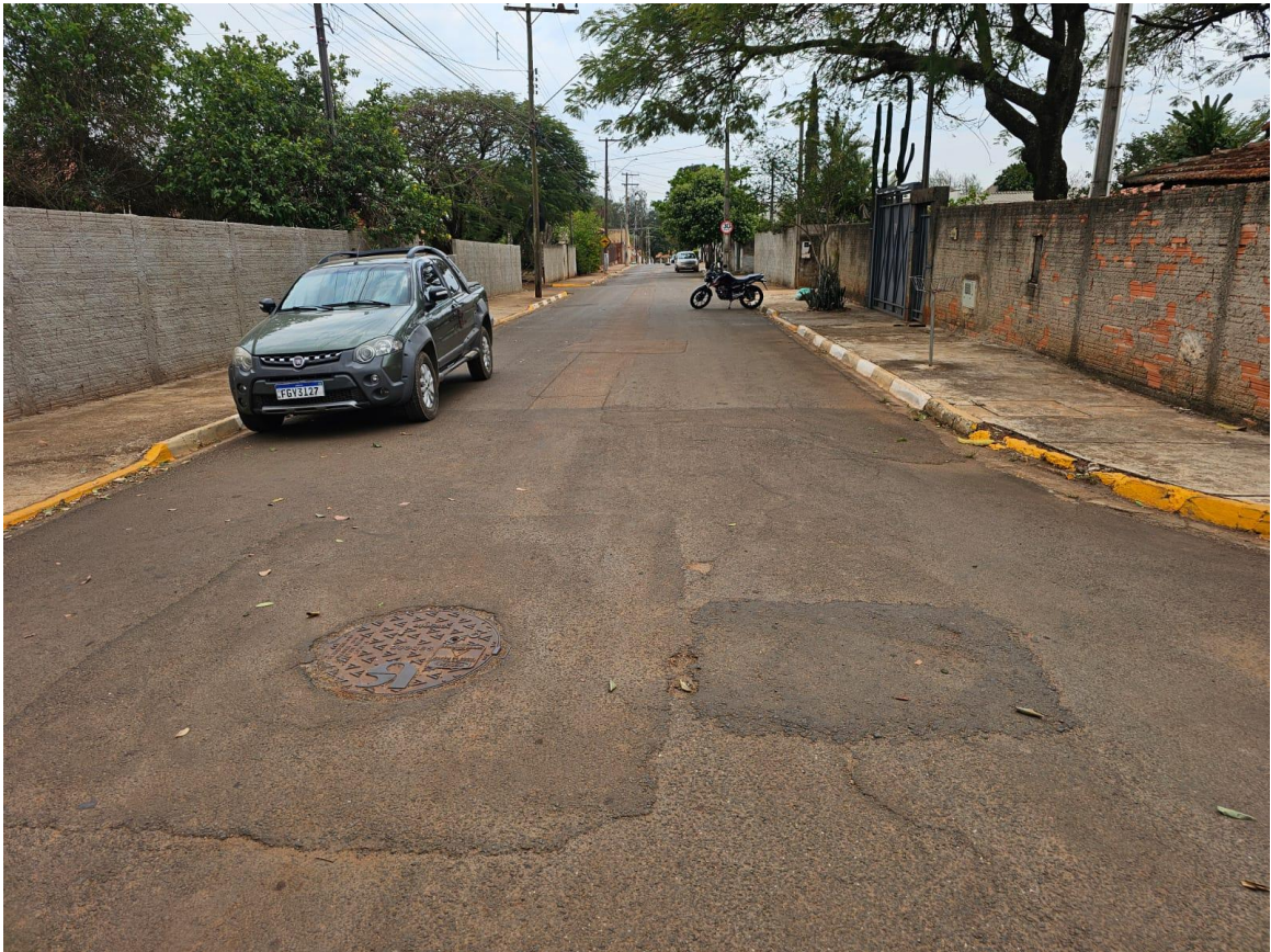
Foto 07: Início do trecho que receberá recapeamento asfáltico da Rua Lázaro Ribeiro da Silva.
