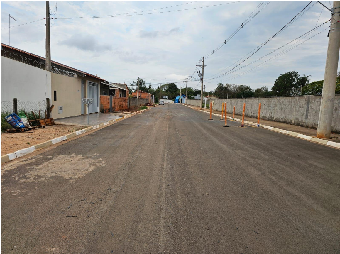
Foto 12: Trecho que receberá recapeamento asfáltico da Rua Maria Ap. Camargo Barros.
