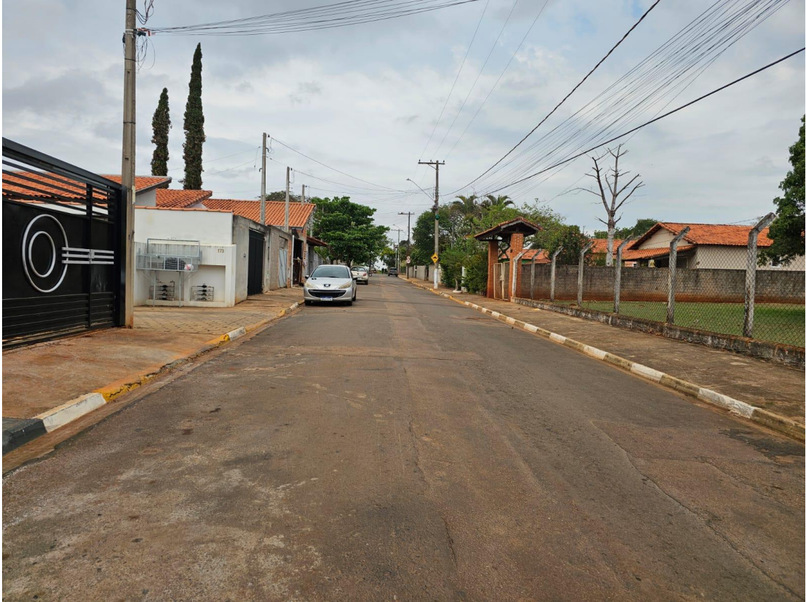
Foto 09: Trecho que receberá recapeamento asfáltico da Rua Lázaro Ribeiro da Silva.
