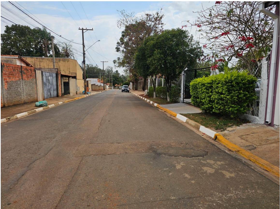
Foto 08: Trecho que receberá recapeamento asfáltico da Rua Lázaro Ribeiro da Silva.
