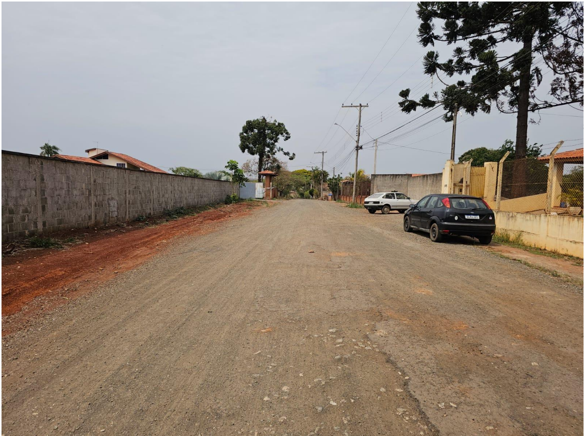
Foto 03: Trecho a ser pavimentado da Rua Lázaro Ribeiro da Silva.
