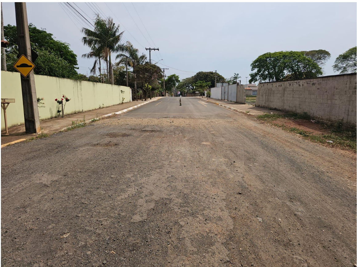
Foto 02: Início do trecho a ser pavimentado da Rua Lázaro Ribeiro da Silva, outro ângulo.
