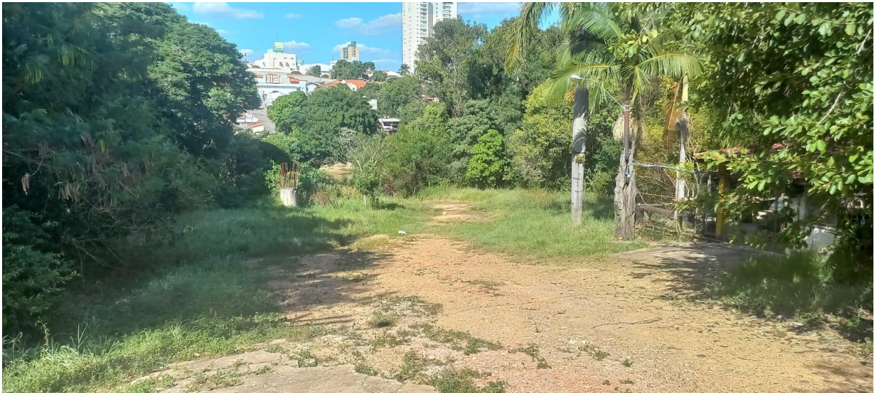
Imagem 05: Foto da margem direita do Rio Tietê onde estão localizados os tubulões T5, T6, T7 e T8.
