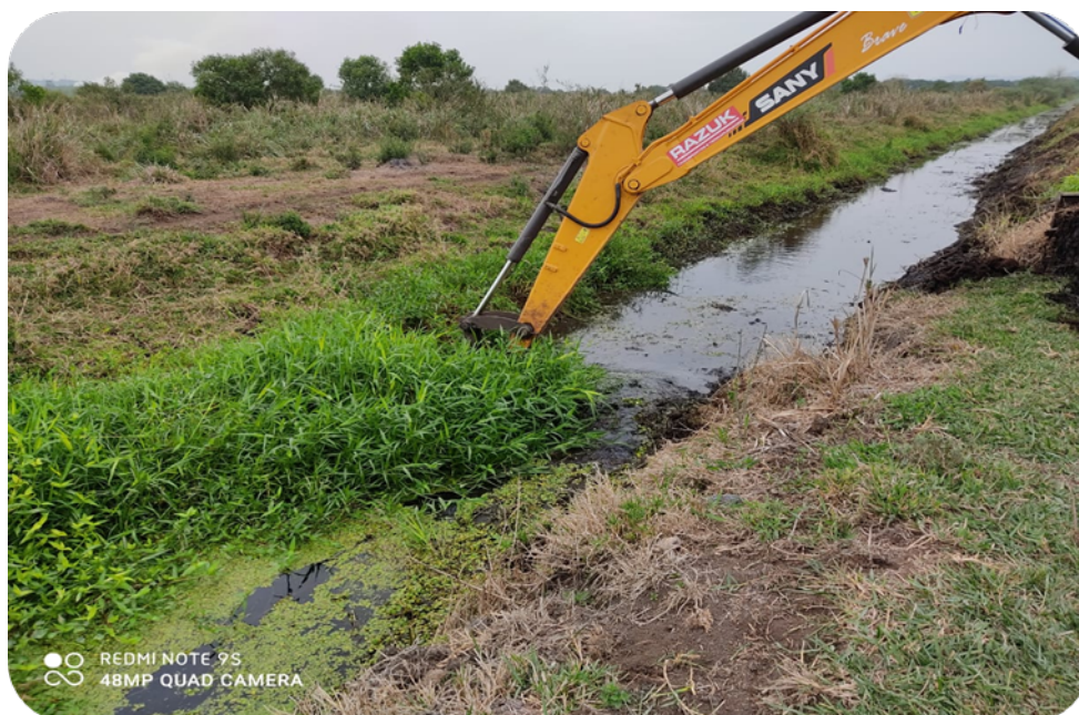
Figura 2 - Desassoreamento mecânico na Vala dos Verdureiros, Região Oeste de São José dos Campos.
