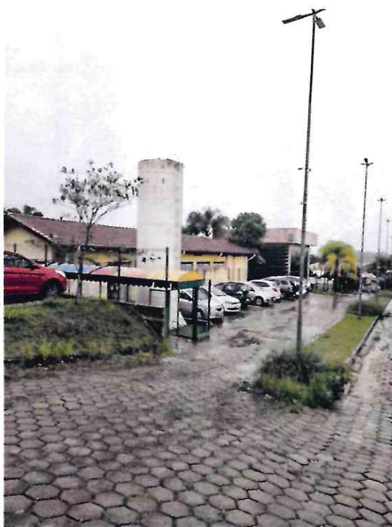
Figura 1 - Reservatório metálico da EMEI PROF a EUTERPE SILVA QUISSAK BARTELEGA.
