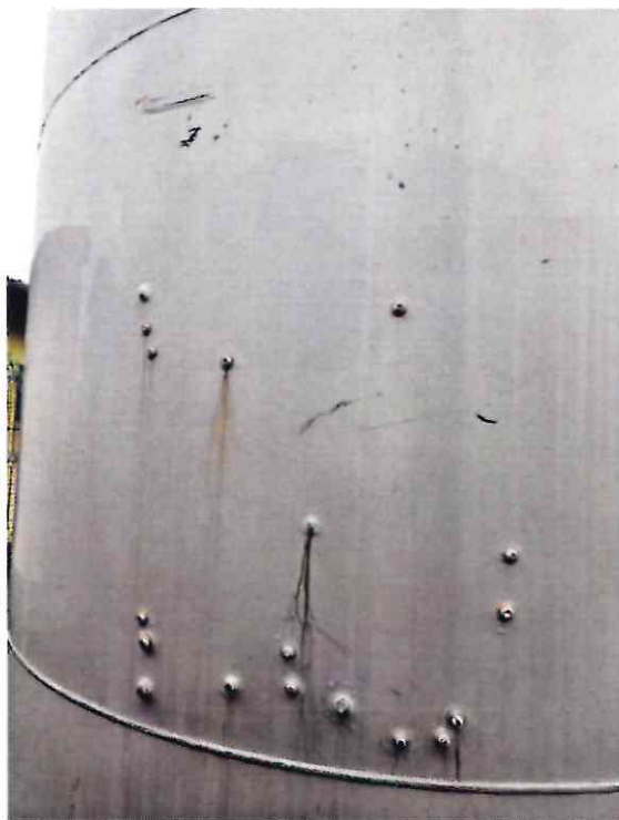
Figura 9 - Furos reparados na estrutura.
