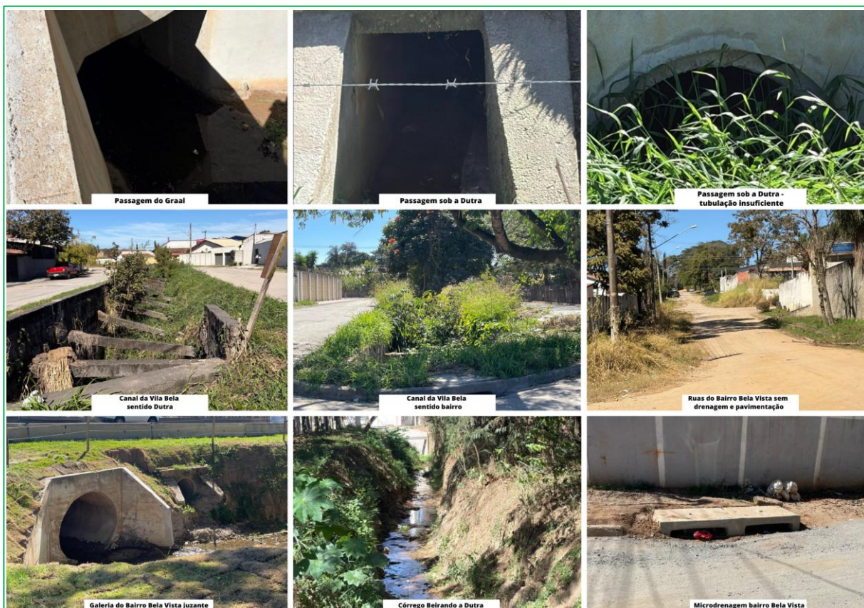
Figuras 2 a 10 – Registros fotográficos de campo realizados em 17/07/2026, evidenciando as condições da drenagem urbana, das travessias hidráulicas, dos canais e galerias existentes
