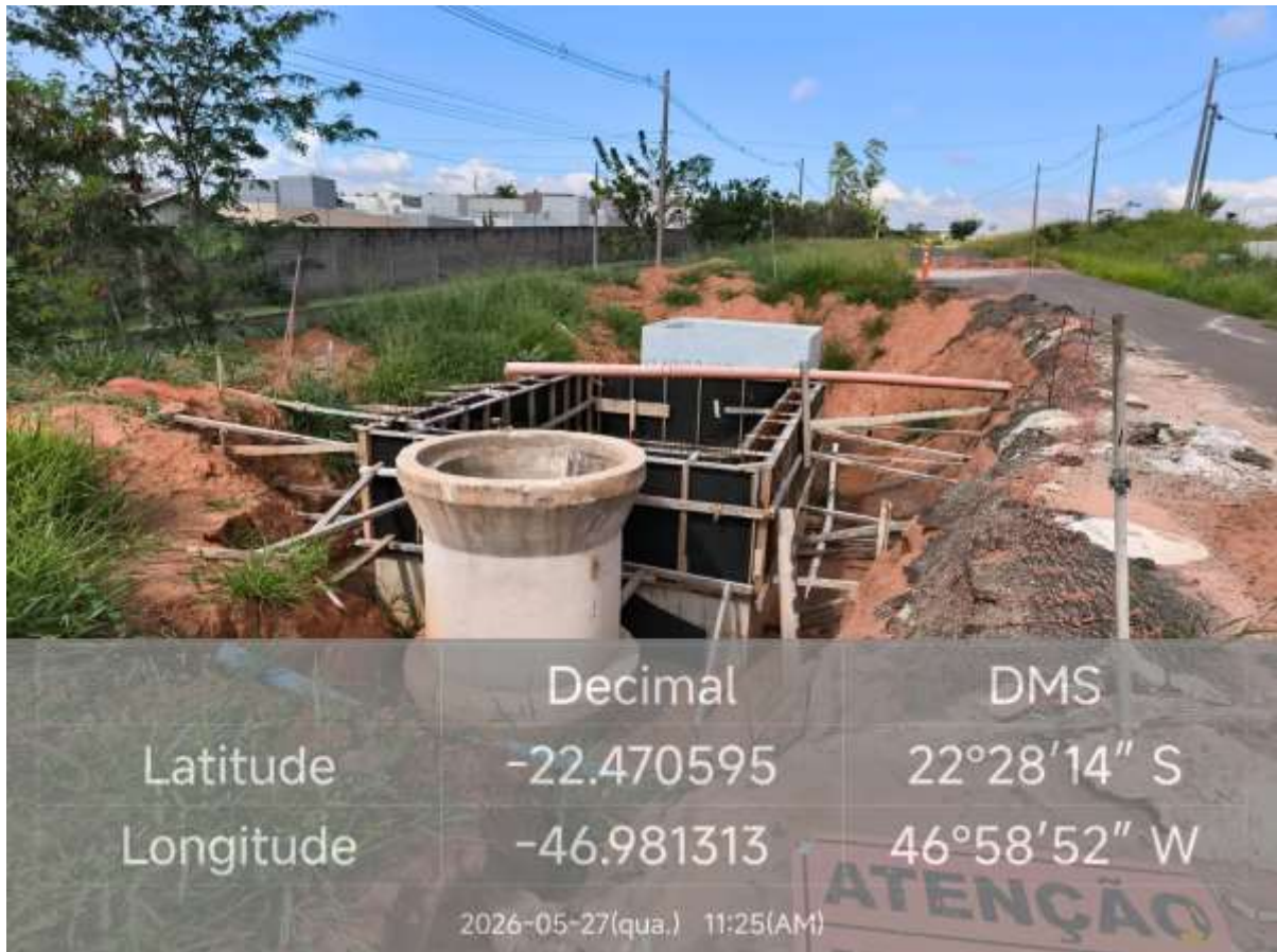
Foto 02: Outra Vista do Poço de Vista (chegada do esgoto na Estação Elevatória de Esgoto), no meio o TANQUE PULMÃO e no fundo o Abrigo em Aduelas de Concreto que vai abrigar o BOOSTER.
