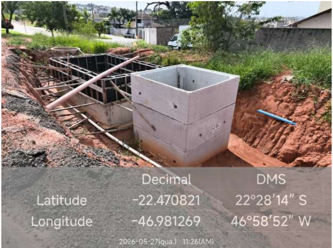
Foto-01: Vista do Poço de Vista (chegada do esgoto na Estação Elevatória de Esgoto), atrás do TANQUE PULMÃO e na frente o Abrigo em Aduelas de Concreto que vai abrigar o BOOSTER.
