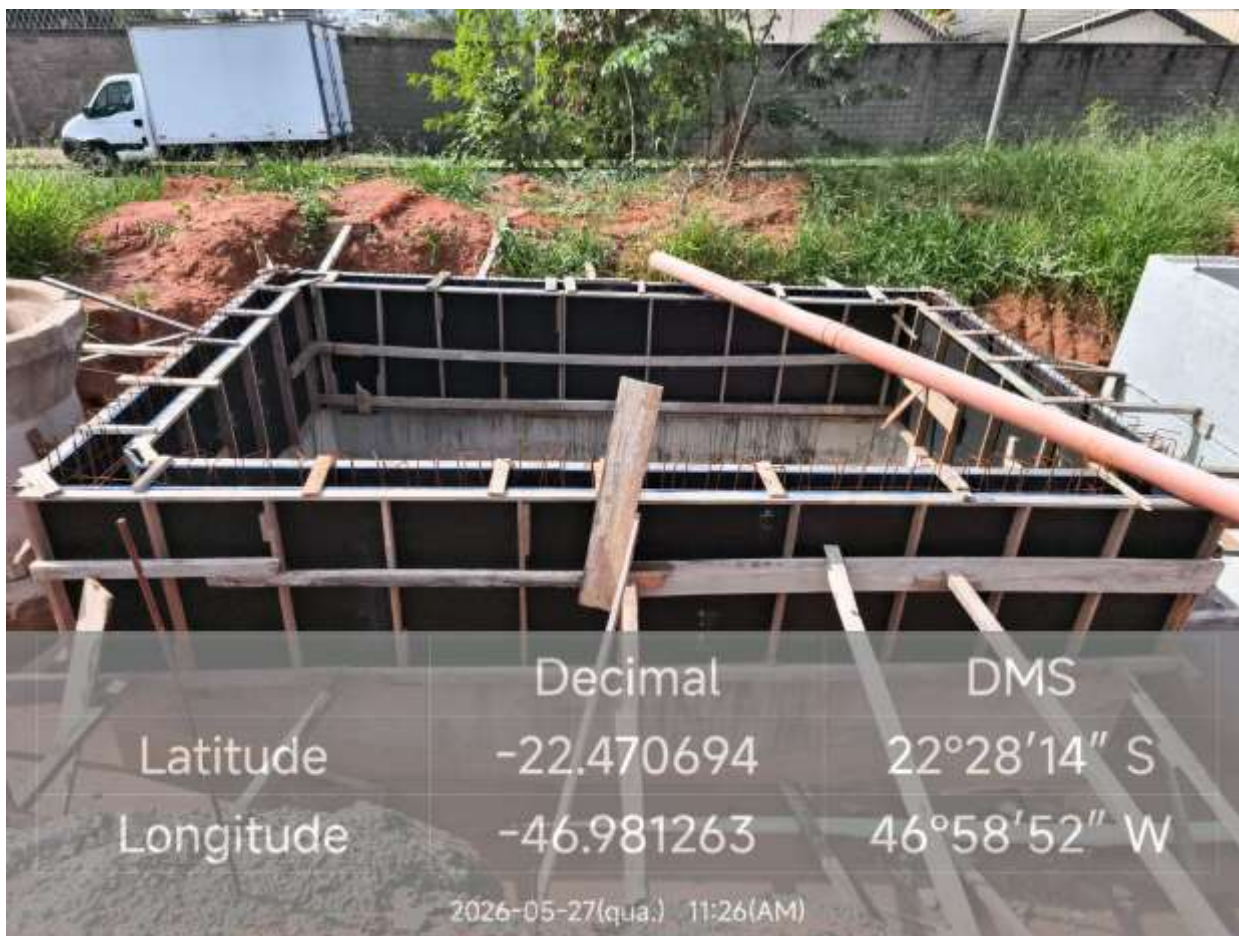
Foto: 03- Vista do TANQUE PULMÃO, entre o POÇO DE VIISITA e o ABRIGO PARA O BOOESTER
