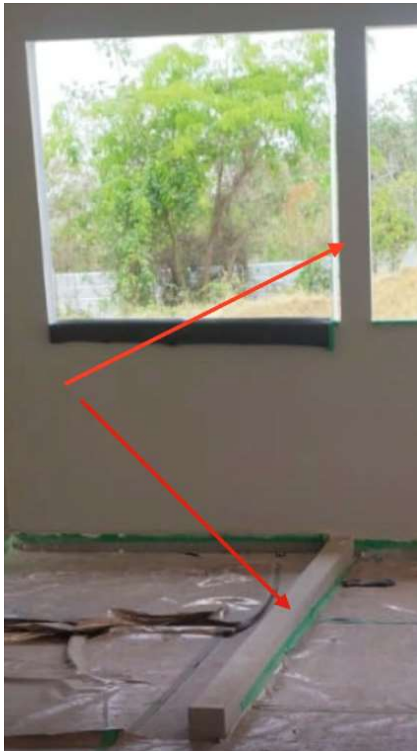
Local de instalação do painel ripado (sapata e entre duas janelas)
