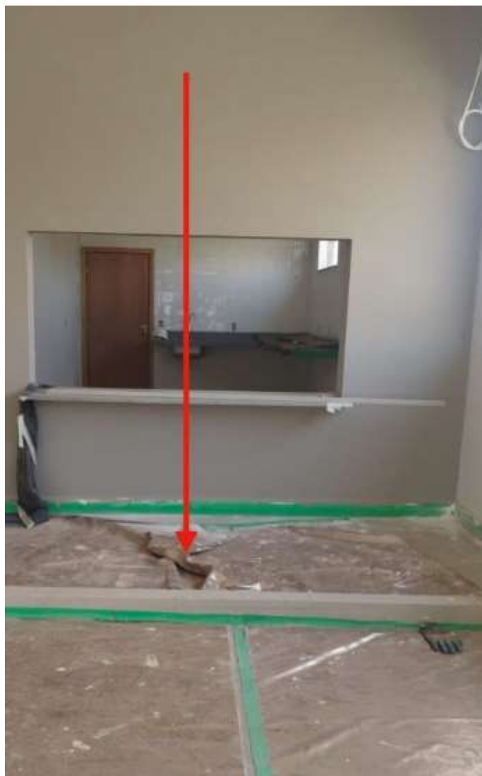
Sapata onde será instalado o painel ripado
