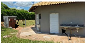
Figura 1. Ilustração da pia instalada.
