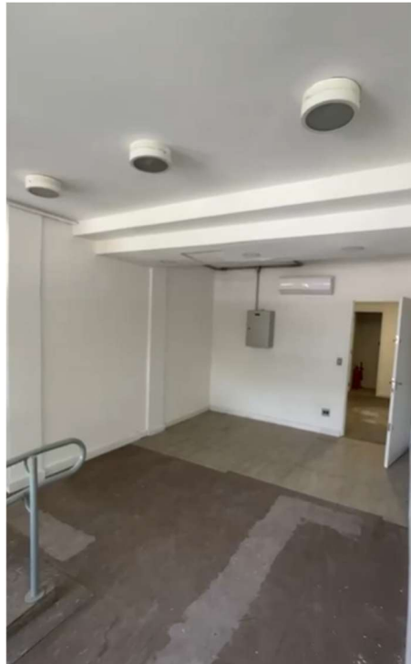
Futura sala da supervisão (nivelar forro, divisória de vidro, piso)
