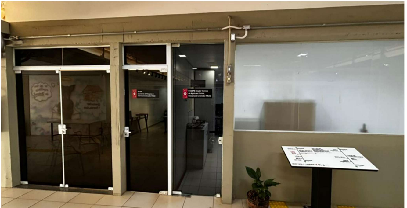
Fachada a ser adequada: Porta central com 2 folhas, porta lateral a ser retirada, para execução de mureta e vidro
