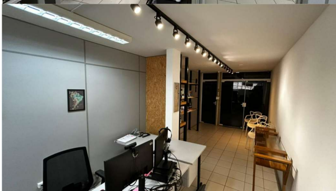
Adequação de divisórias, elétrica, iluminação
