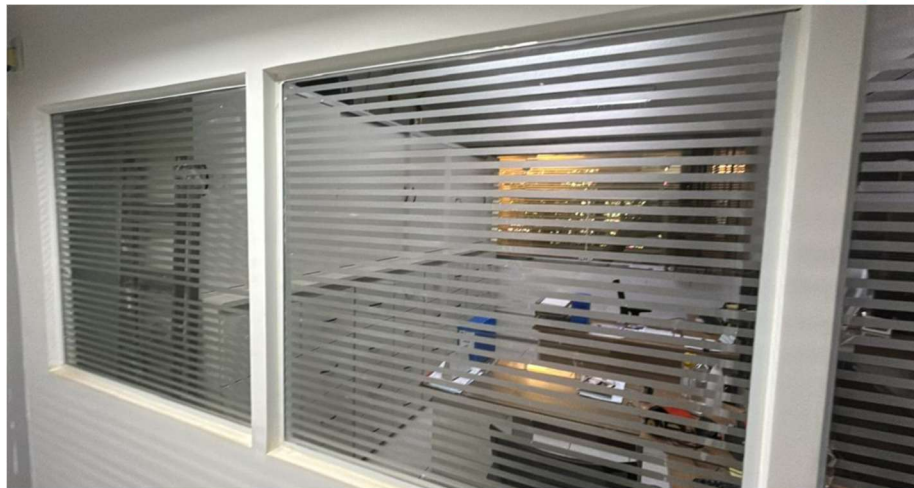
Vidro a ser fechado com drywall (Sala de reuniões)
