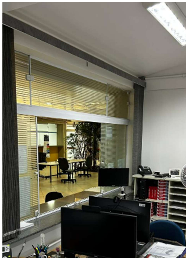
Realizar abertura de vão para porta (Lado oposto ao rebaixado)
