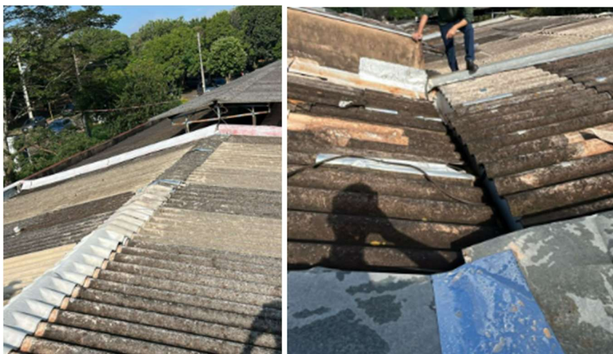
Pontos do telhado a serem reparados
