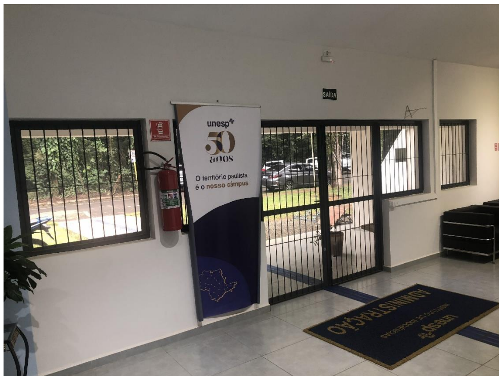
ITEM 6 e 7 - Janelas Hall de Entrada
