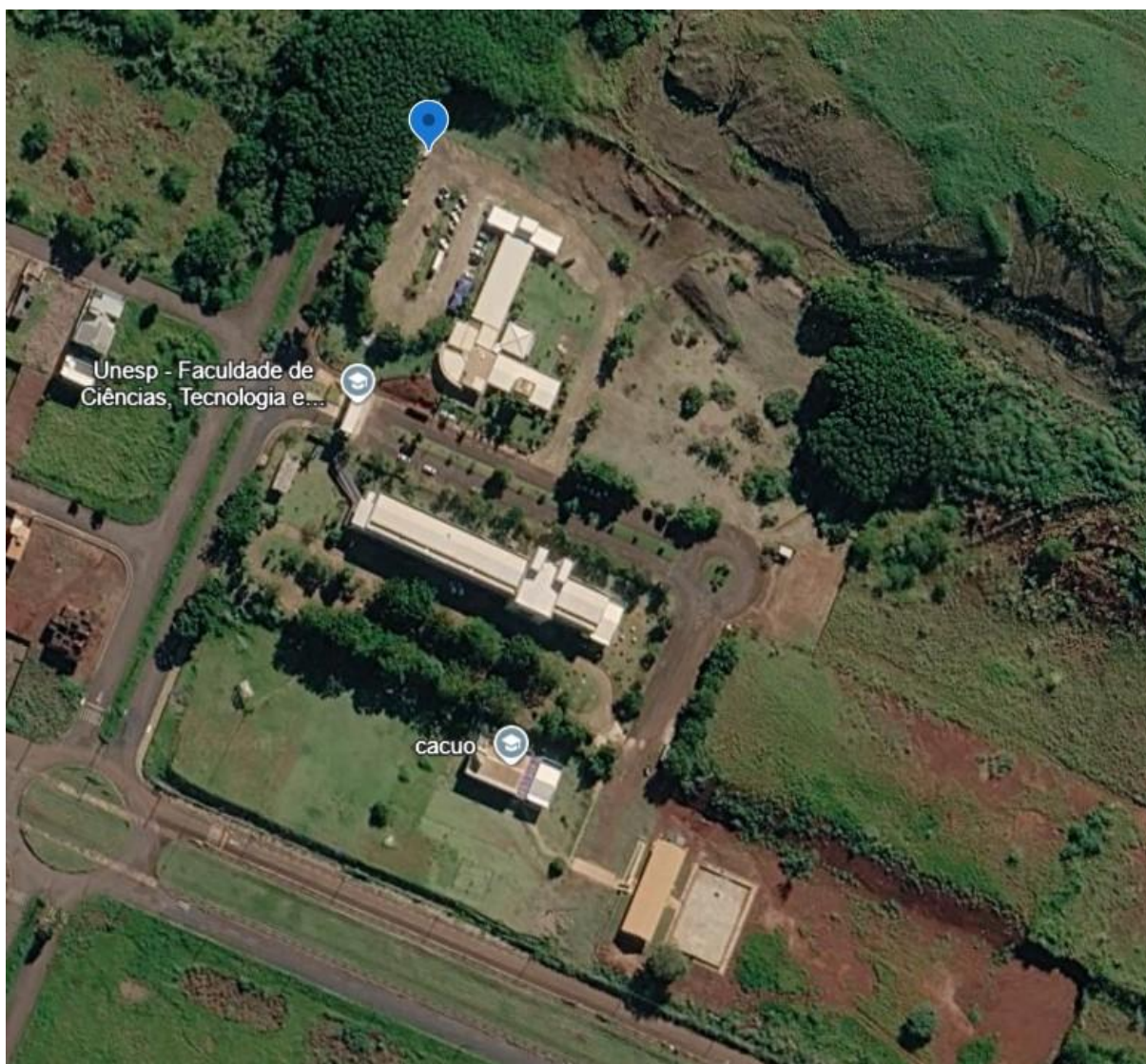
Figura 1 – Indicação do local para execução dos furos de sondagem.
