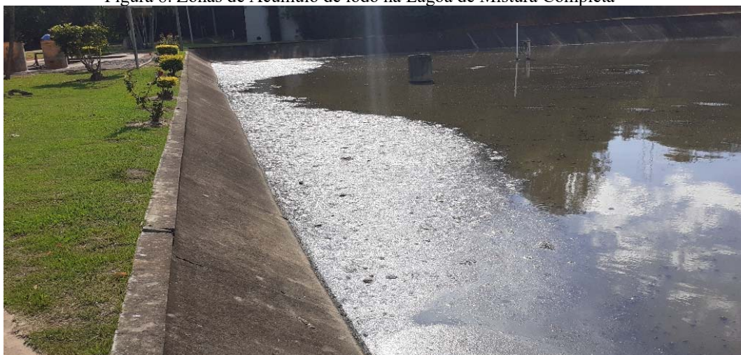
Figura 8. Zonas de Acumulo de lodo na Lagoa de Mistura Completa
