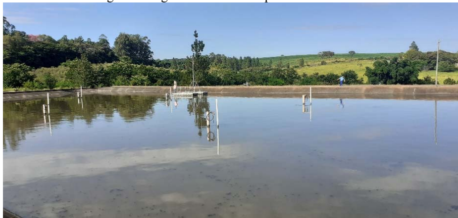
Figura 9. Lagoa de mistura completa com aeradores
