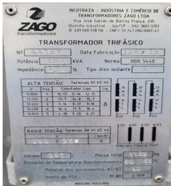
Dados de placa transformador 01 a ser instalado
