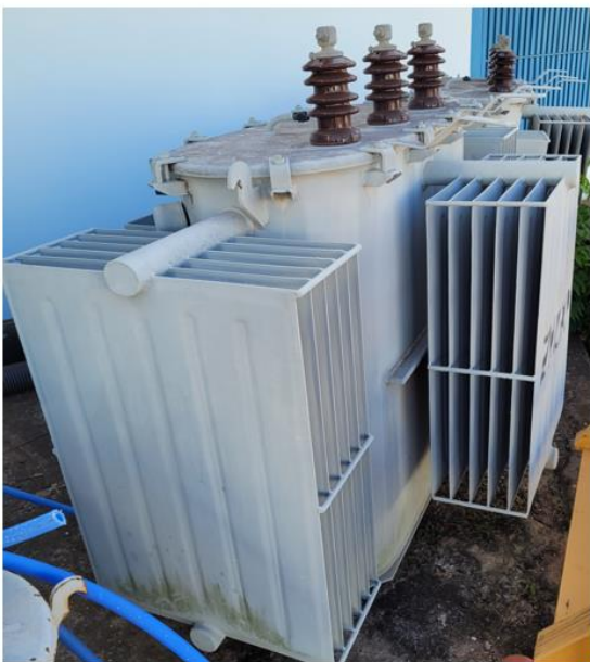
Transformador 01 a ser instalado na cabine
