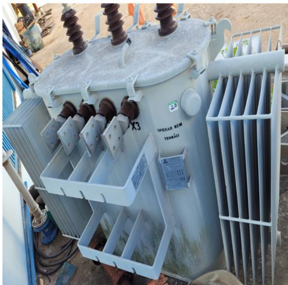
Transformador 02 a ser instalado na cabine
