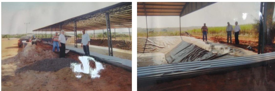
Fotos 39 e 40 – Vista geral da LAGOA 02, coberta e com PEAD;
