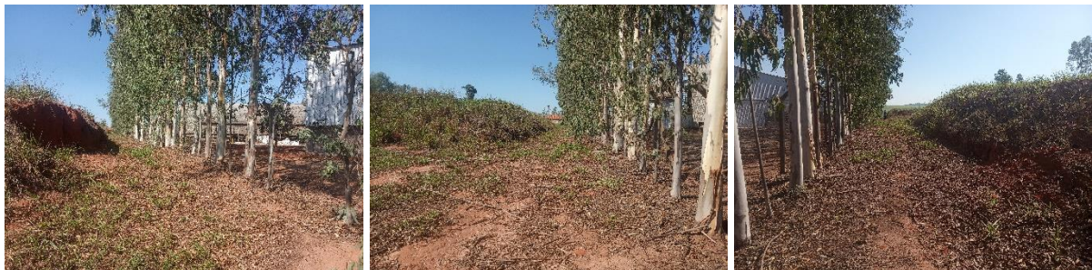
Fotos 34 a 36 – Vista do espaço entre a saia das lagoas e o alambrado, divisa com a empresa Êxito Rural a oeste e a jusante;
