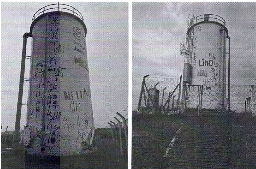
Imagem 06 – Estado atual do reservatório
