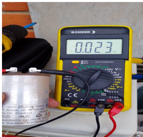
Imagem do capacitor de 25 uF da condensadora
