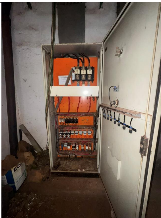
Foto 19: Ar condicionado central – remoção total.
