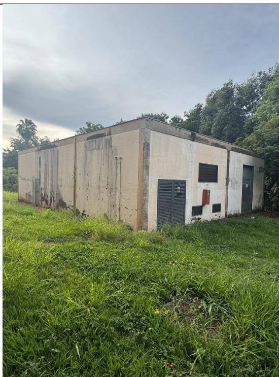
Foto 09: Conduitor de águas pluviais com vazamento e danificando elementos contruídos.
