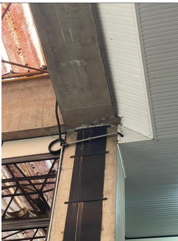
Foto 05: Vazamento da cobertura em dias de chuvas.
