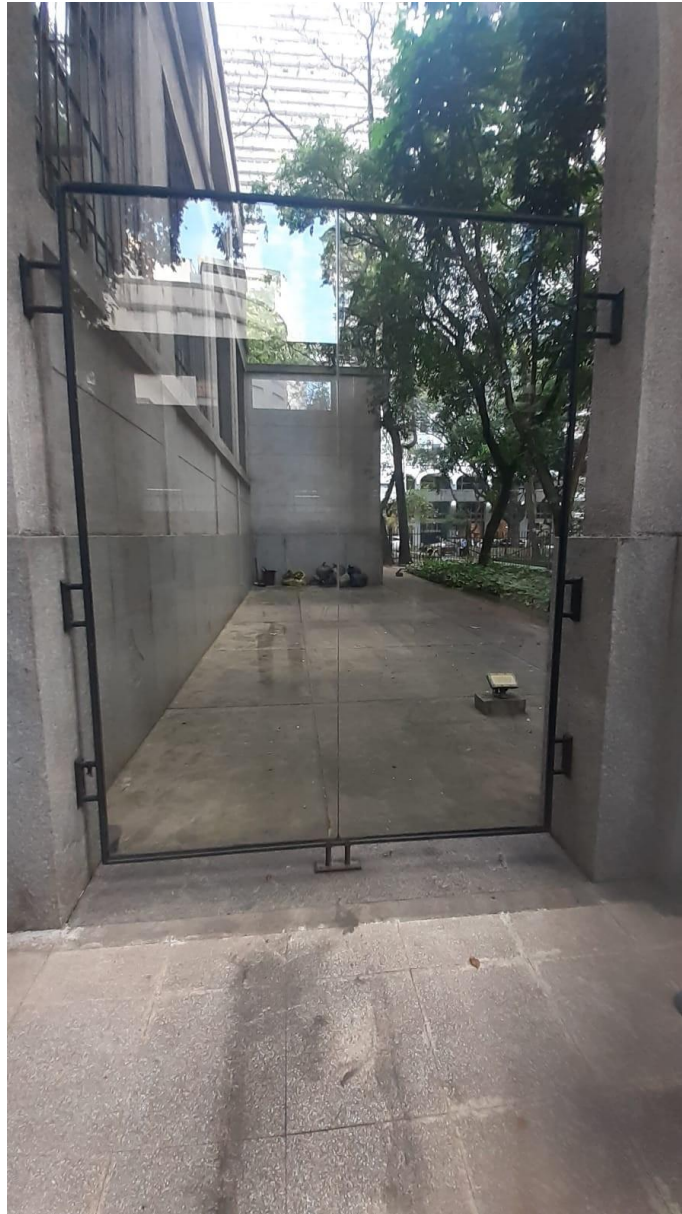
Figura 1 - Local da instalação do portão
