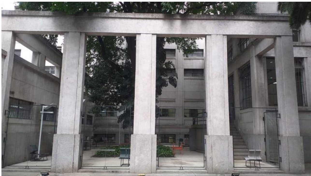
Figuras 2 e 3 - Visão geral do local
