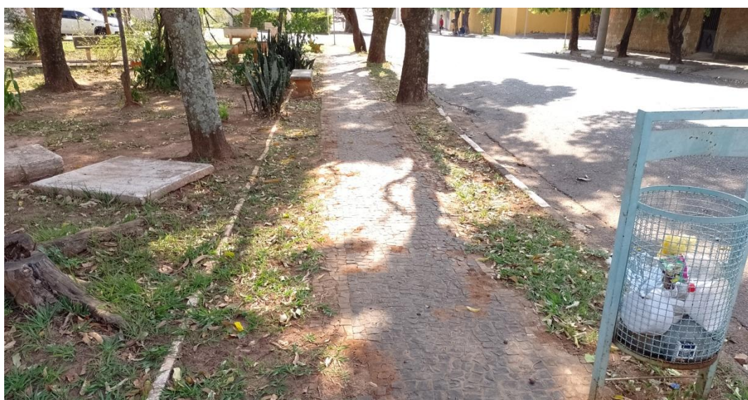
Figura 4 - Calçada a ser substituída por calçada em concreto.
