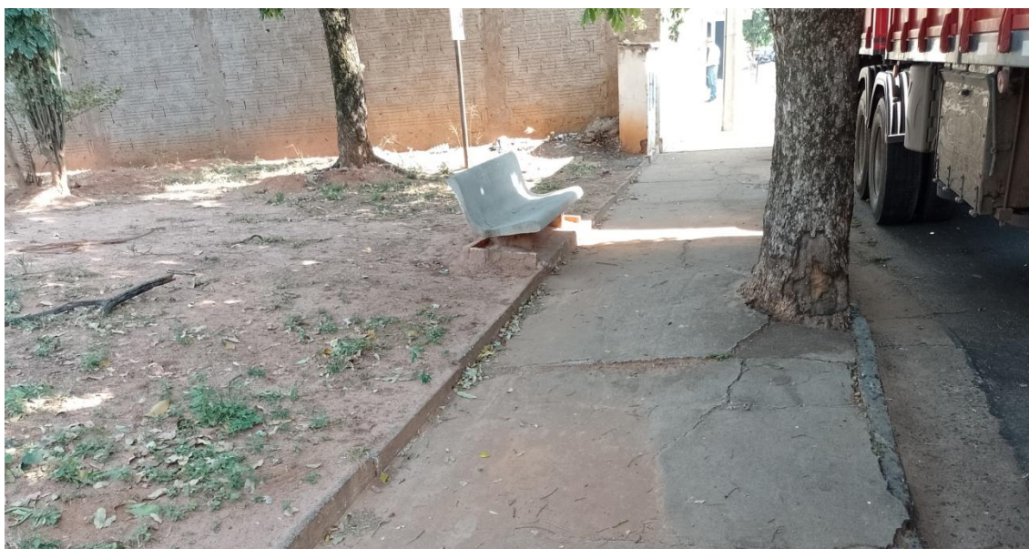
Figura 7 - Demolição e execução de guias e calçada.
