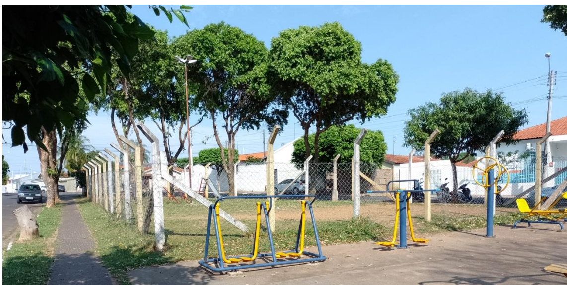
Figura 1 - Tela de alambrado a ser substituída.
