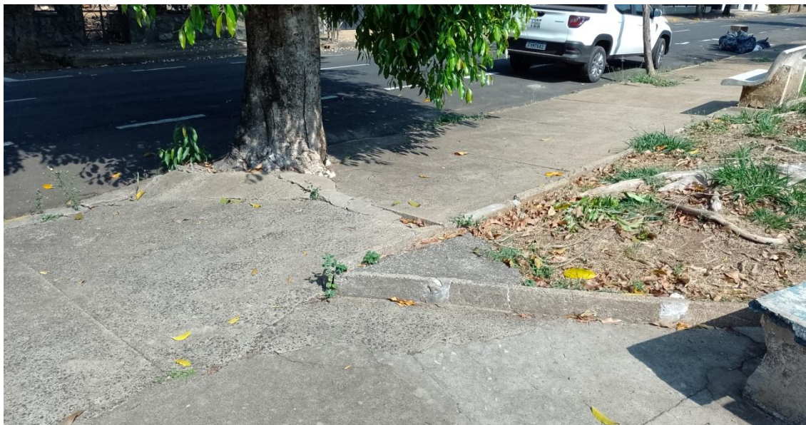
Figura 6 - Demolição e execução de guias e calçada.
