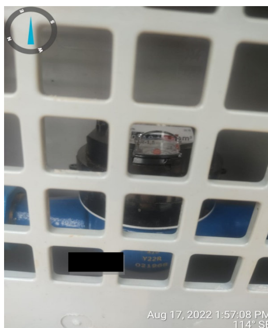
Figura 3 - Ressalto se sobrepondo aos roletes de medição impedindo a leitura do hidrômetro.
