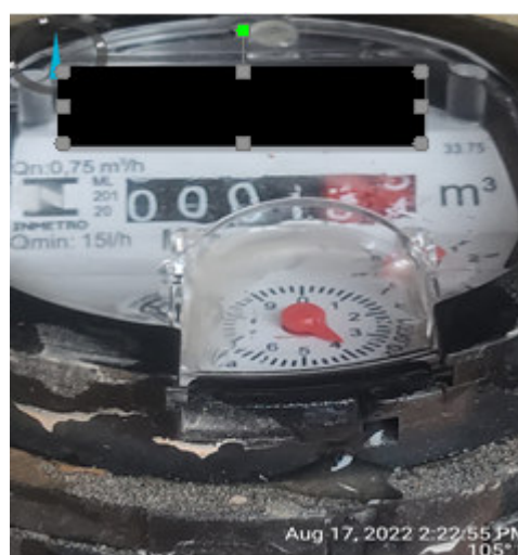
Figura 2 - Ressalto identificado em hidrômetro instalado no município impedindo a correta interpretação da leitura
