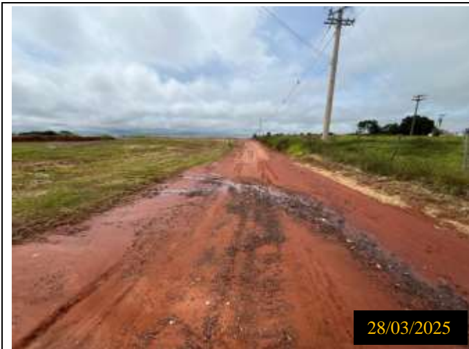
Figura 01: Local da obra - Rua Ulisses Candido
