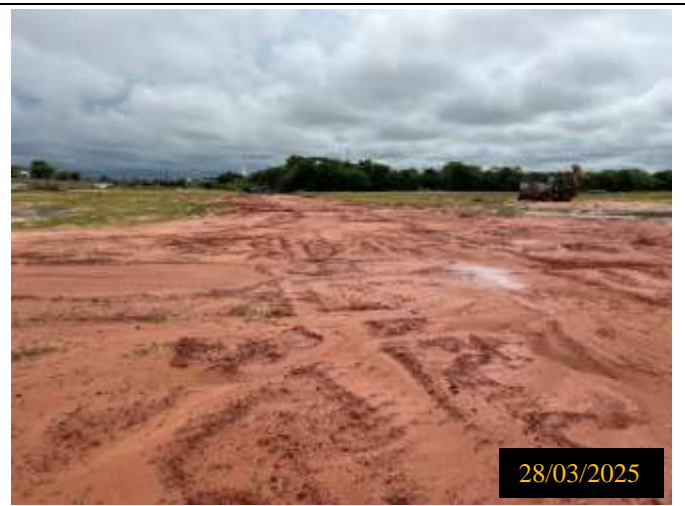
Figura 02: Local da obra - Rua Ulisses Candido
