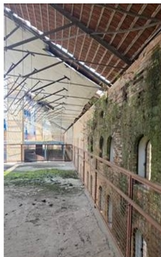
Foto 07 – Vegetação da fachada a ser removida e piso a sofrer lavagem por hidrojetamento
