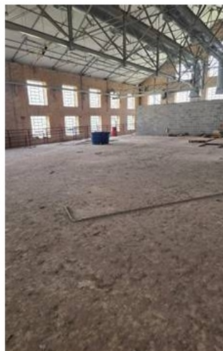
Foto 08 –Piso a sofrer lavagem por hidrojetamento
