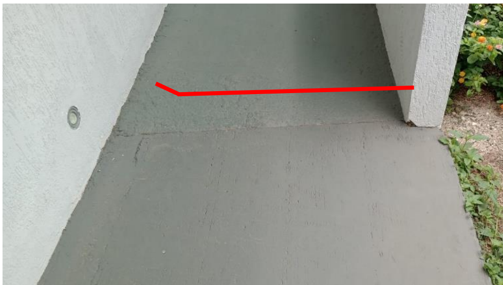
Imagem 3: Local de passagem do conduíte
