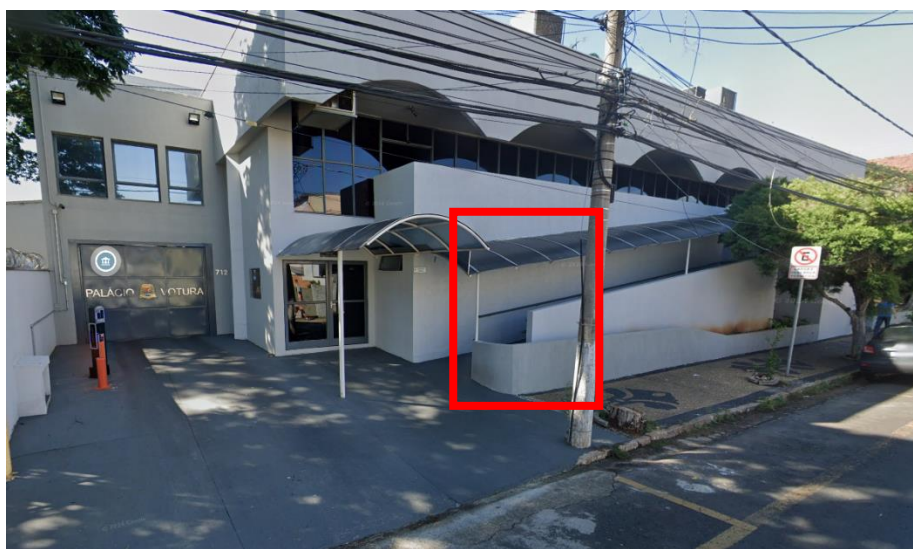
Imagem 1: Visão geral área da instalação
