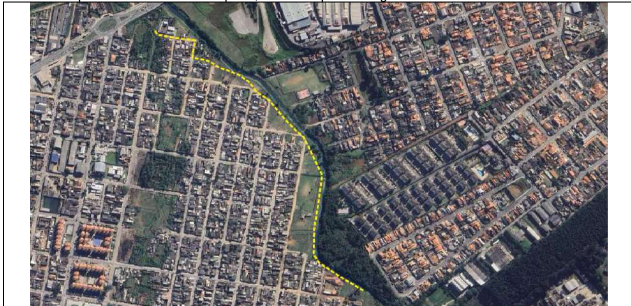
Figura 1. Representação geral do coletor tronco de esgotos brutos Rio Jundiá – trecho prioritário, no Bairro Nova Jundiapéba - Distrito de Jundiapéba, no município de Mogi das Cruzes – SP.
