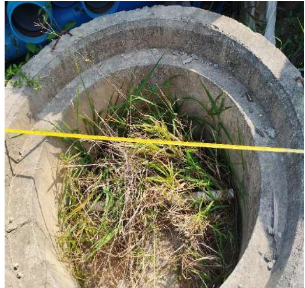
Modelo de Encaixe tipo PONTA/BOLSA (anel de concreto/ Aduela de concreto)
