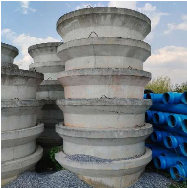
Modelo de Encaixe tipo MACHO/FÊMEA (anel de concreto/Aduela de concreto)
