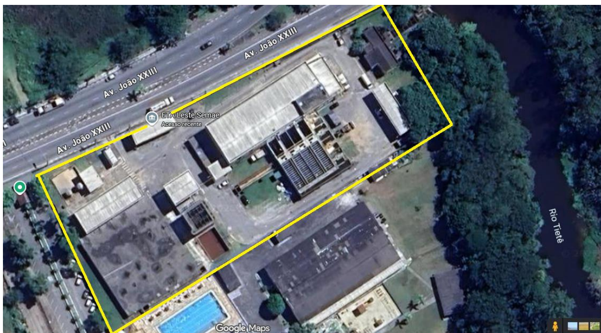
Imagem 1 – Vista aérea da ETA LESTE
