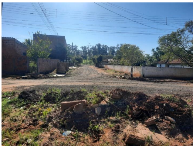
Foto 01 – Obra de Galeria pluvial em andamento na Rua Rio de Janeiro com a Rua Dr. Julio Prestes
