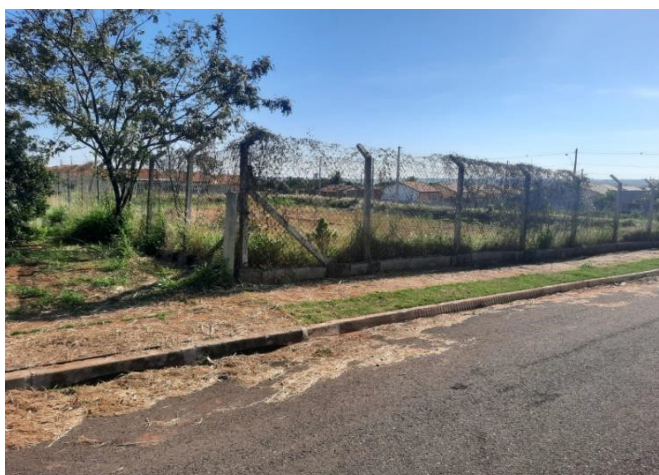
Foto 05 – Piscinão para contenção de águas pluviais situado no prolongamento da Rua Dr. Presidente Kennedy
