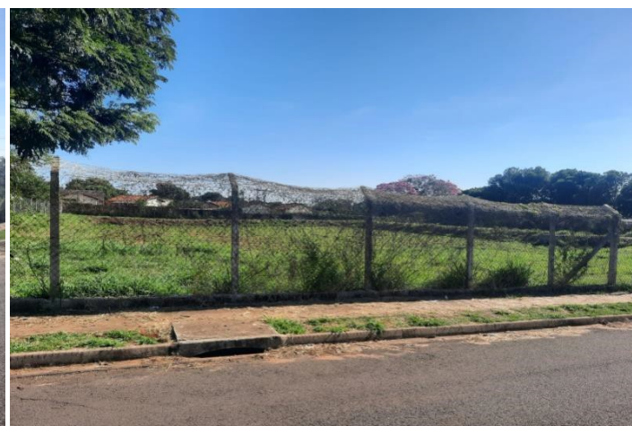
Foto 06 – Piscinão 2 para contenção de águas pluviais situado no prolongamento da Rua Dr. Presidente Kennedy
