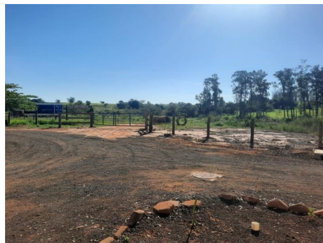
Foto 02 – Obra de Galeria pluvial em andamento na Rua Rio de Janeiro com a Rua Av. São Paulo
