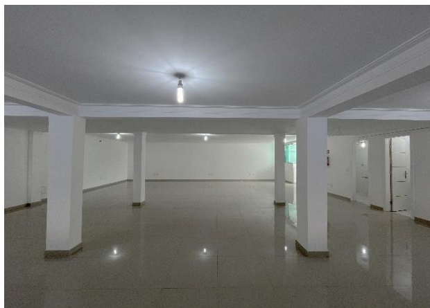
FOTO 07: Segundo Pavimento I Sobreloja
