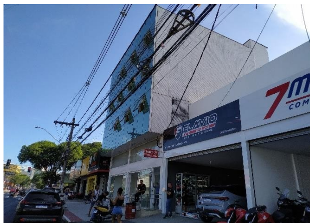
FOTO 02: Fachada lateralizada da edificação
