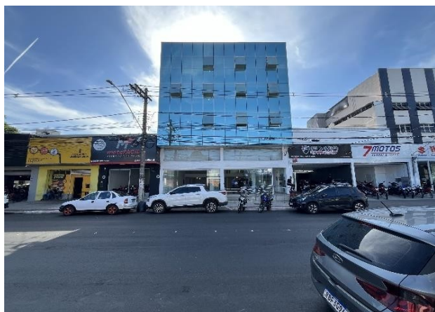
FOTO 01: Fachada principal I Av. Marechal Campos
