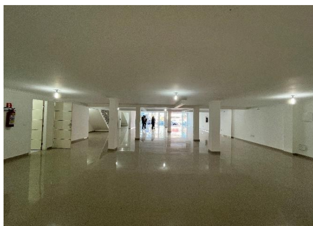
FOTO 06: Salão visto da parte posterior com banheiros à esquerda I Térreo
