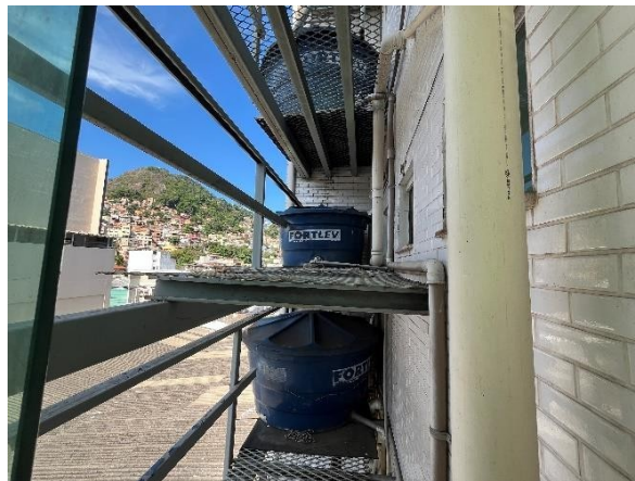
FOTO 14: Espaço destinado aos reservatórios de água
