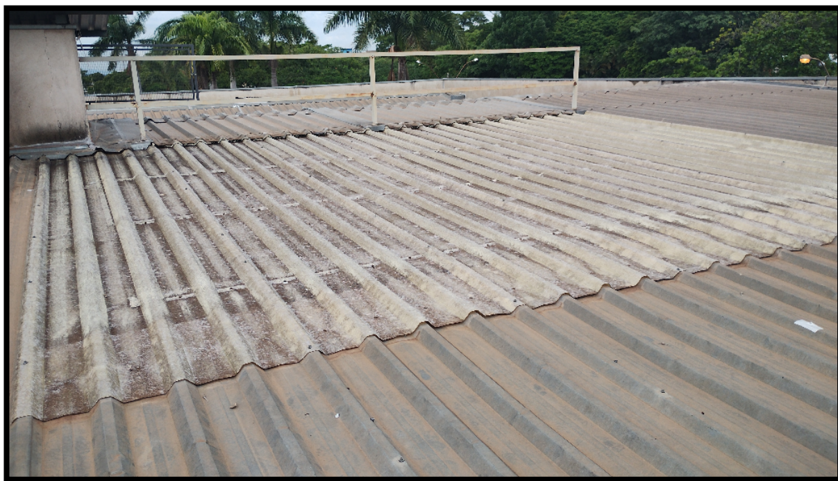
Vista do telhado área onde será removido e instalado as telhas translucidas
