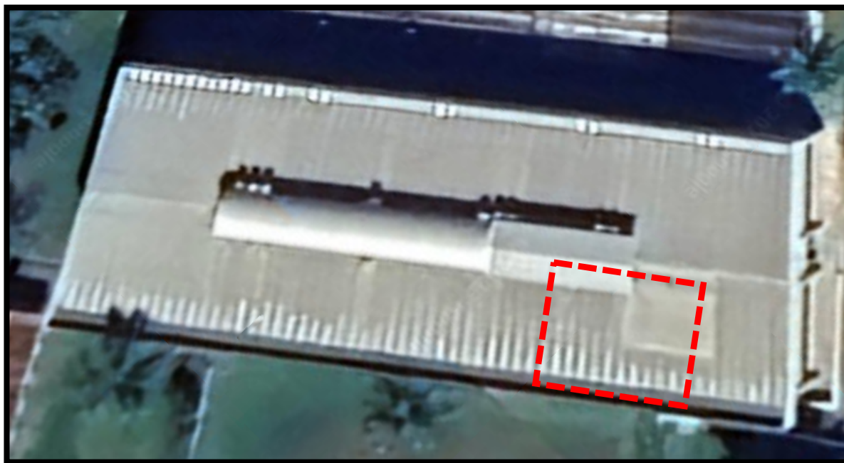
Vista do telhado área onde será removido e instalado as telhas translucidas
