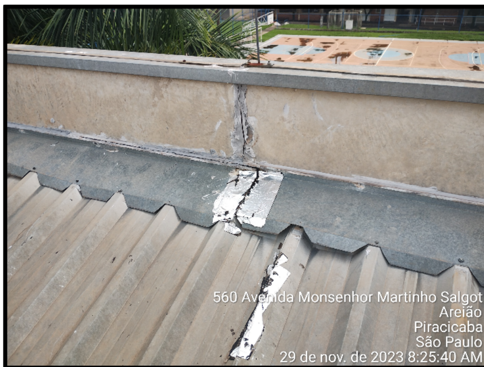
Vista da junta de dilatação, transpasse dos rufos
