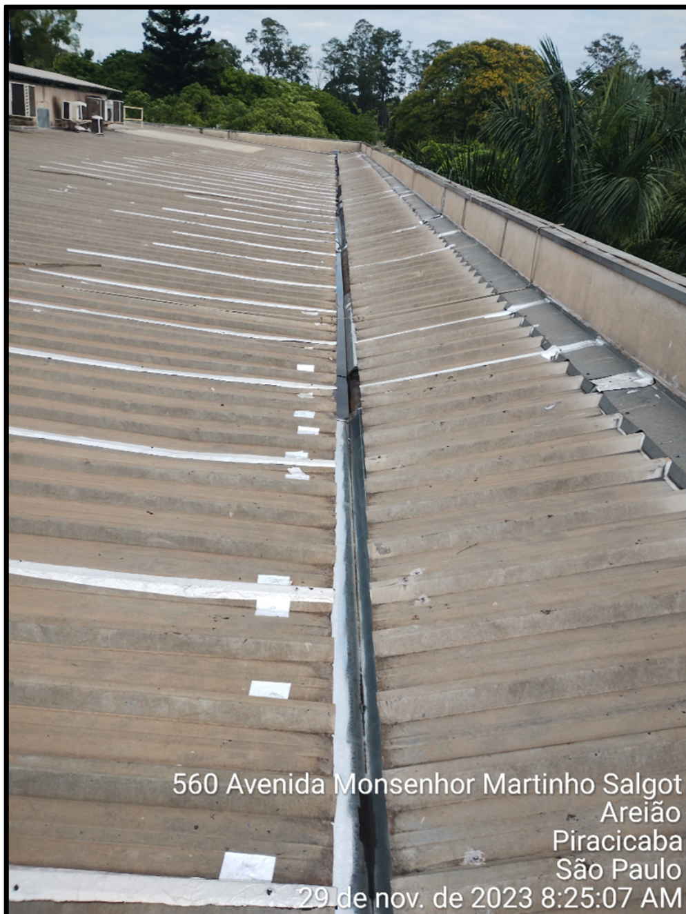
Vista da calha, rufos e pingadeira
