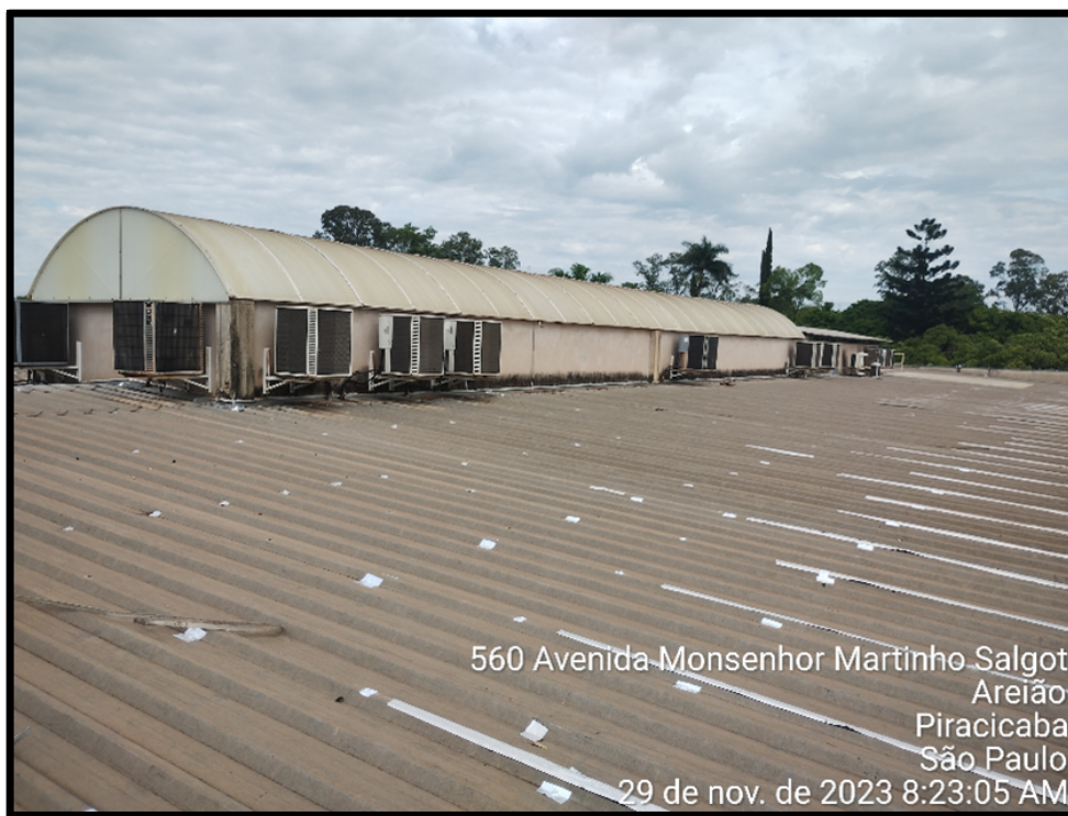
Vista do telhado
