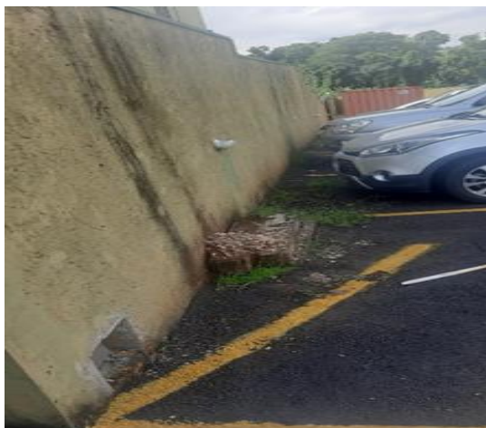
Item 2 Talude localizado nos fundos do prédio
