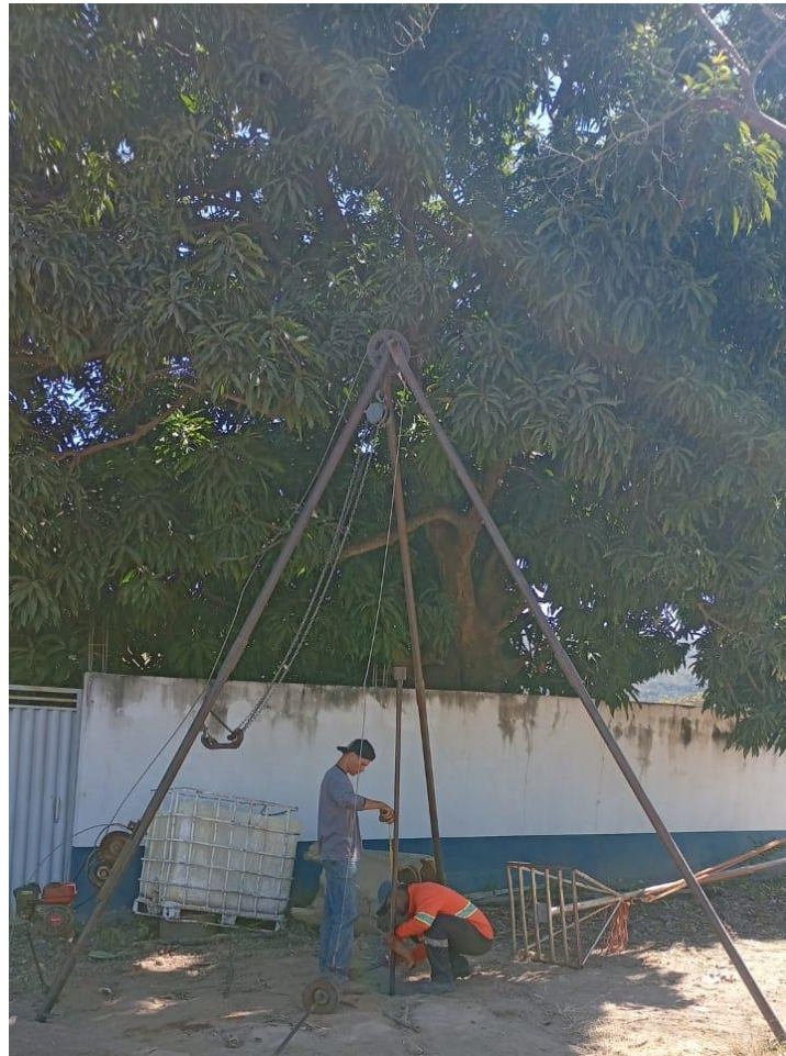
Instalação do Furo SP01
