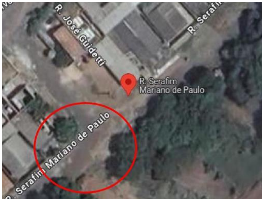
Ponto 08- Rua Serafim Mariano de Paulo/Rua José Guidetti Área com drenagem superficial precária, provocando erosão em área verde.
